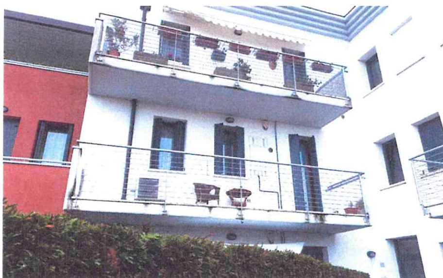
Foto 2: L'appartamento al piano primo
