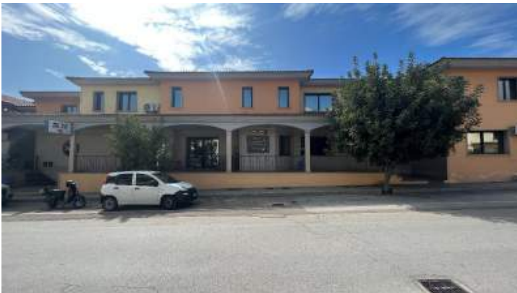
Figura 1 – Viste delle facciate fronte strada del fabbricato
