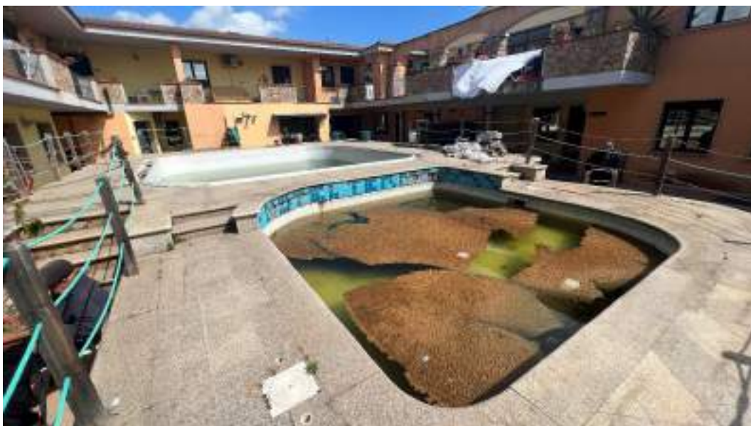
Figura 8 – Viste della corte e delle facciate interne del fabbricato
