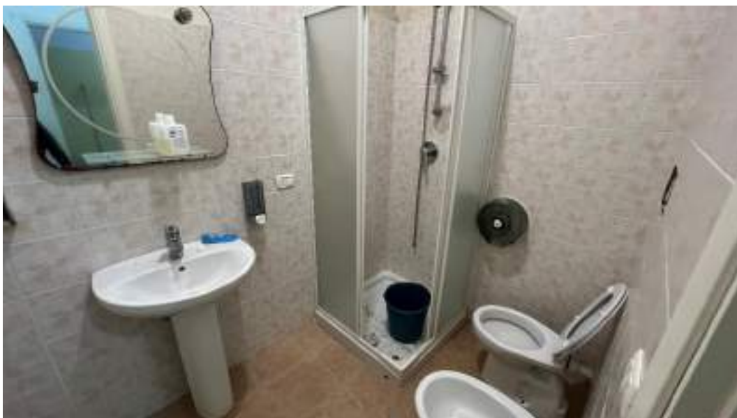
Figura 19 – Viste interne dello spazio adibito a locale Bar – piano interrato
