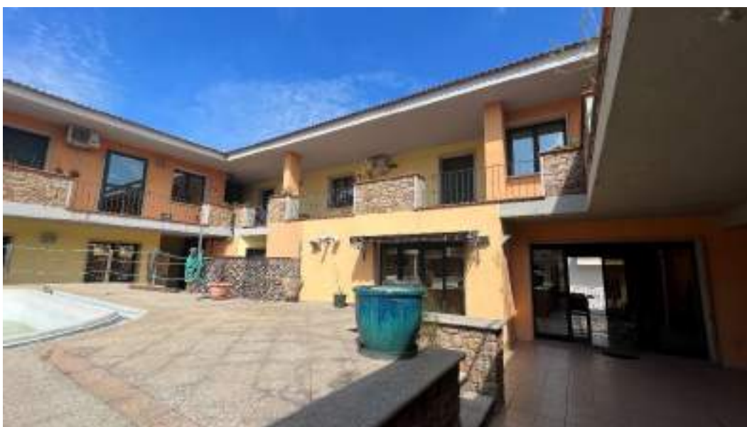
Figura 6 – Viste della corte e delle facciate interne del fabbricato
