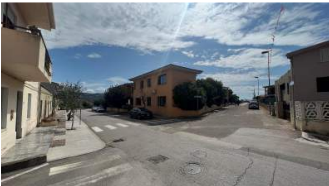
Figura 2 – Viste delle facciate fronte strada del fabbricato
