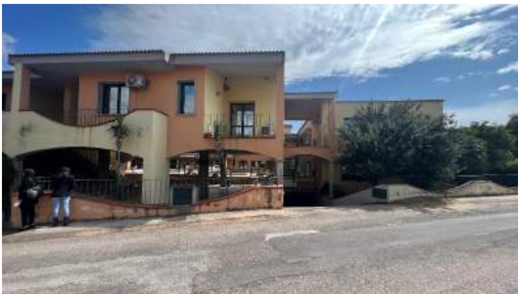
Figura 3 – Viste delle facciate fronte strada del fabbricato
