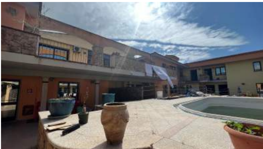
Figura 5 – Viste della corte e delle facciate interne del fabbricato
