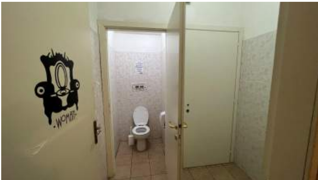
Figura 16 – Viste interne dello spazio adibito a locale Bar – piano interrato
