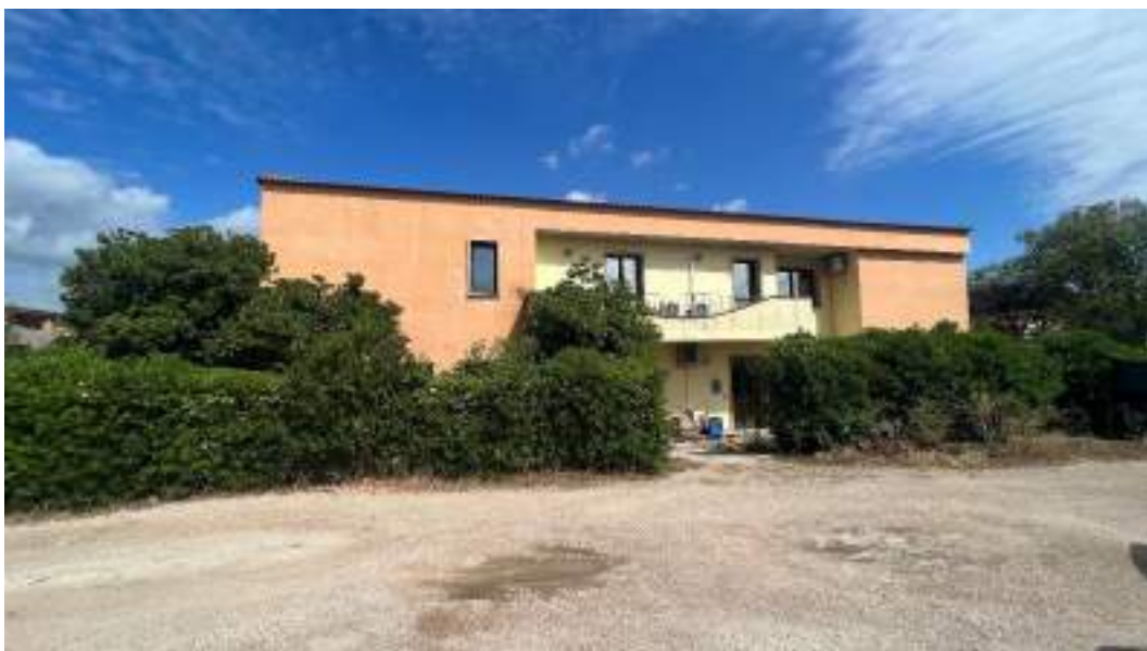
Figura 4 – Viste delle facciate fronte strada del fabbricato
