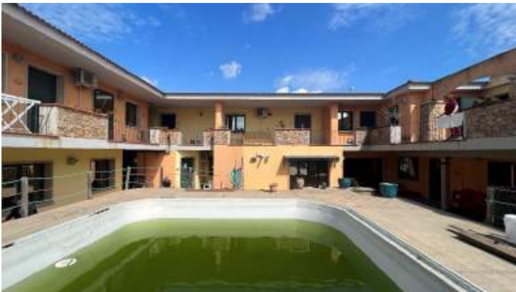
Figura 7 – Viste della corte e delle facciate interne del fabbricato
