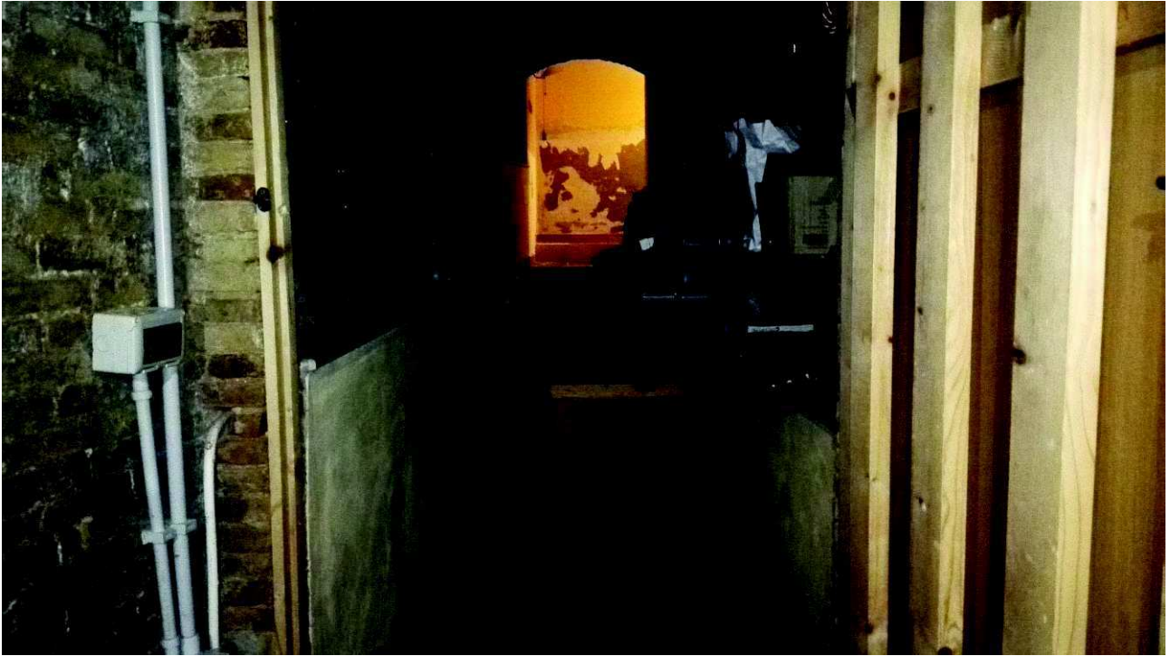
Il corridoio dell'interrato
