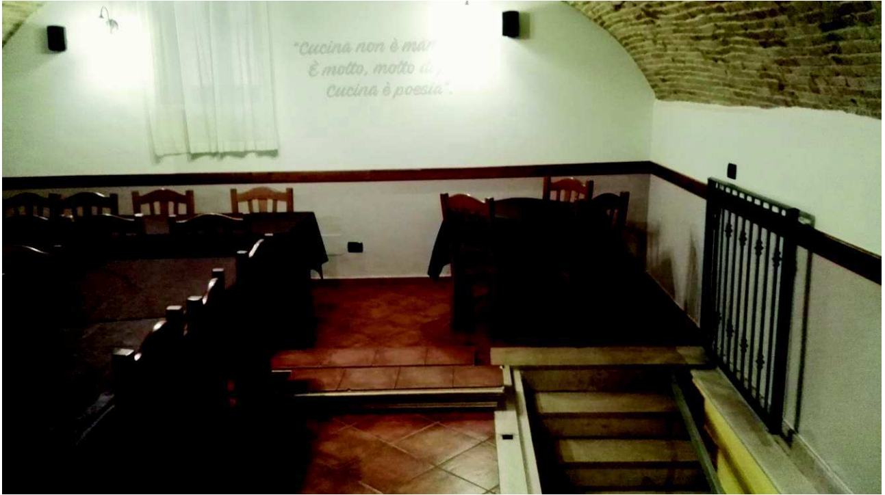
L'interno e la botola con la scalinata che porta all'interrato
