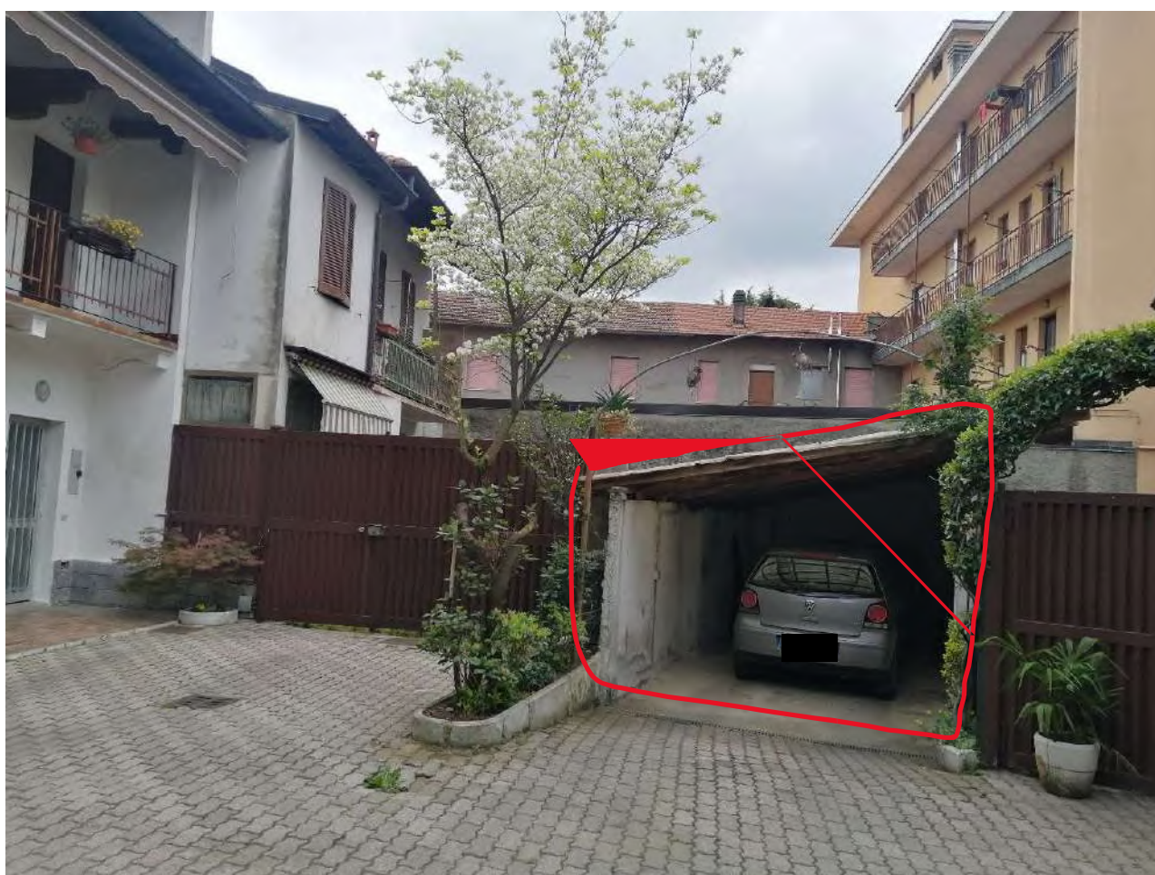
viste da corte interna
