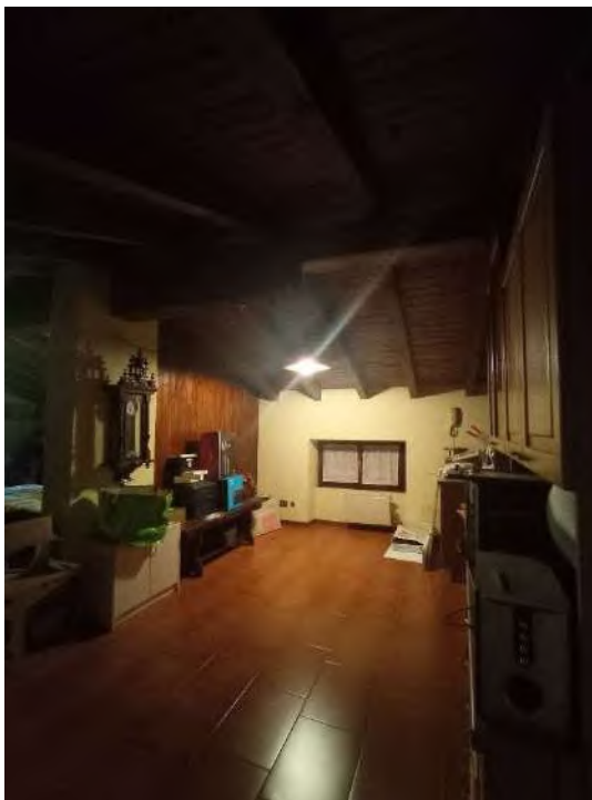
Vano al piano sottotetto
