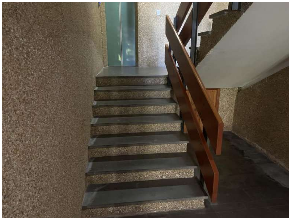
- vano scala/ascensore condominiale
