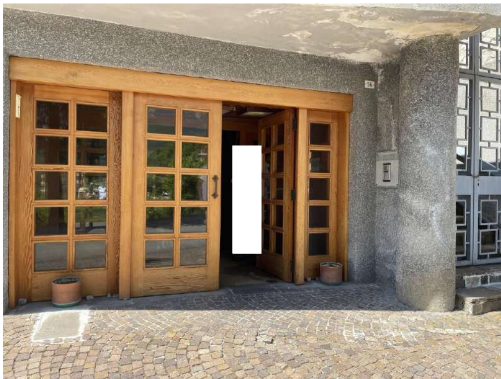
- ingresso portone condominiale
