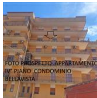
Prospetto dell'appartamento al IV° piano che affaccia sul retro
