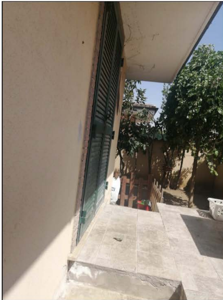
Fotografia numero 4 (quattro) Vista esterna retro fabbricato sempre da area interna pertinenziale –
