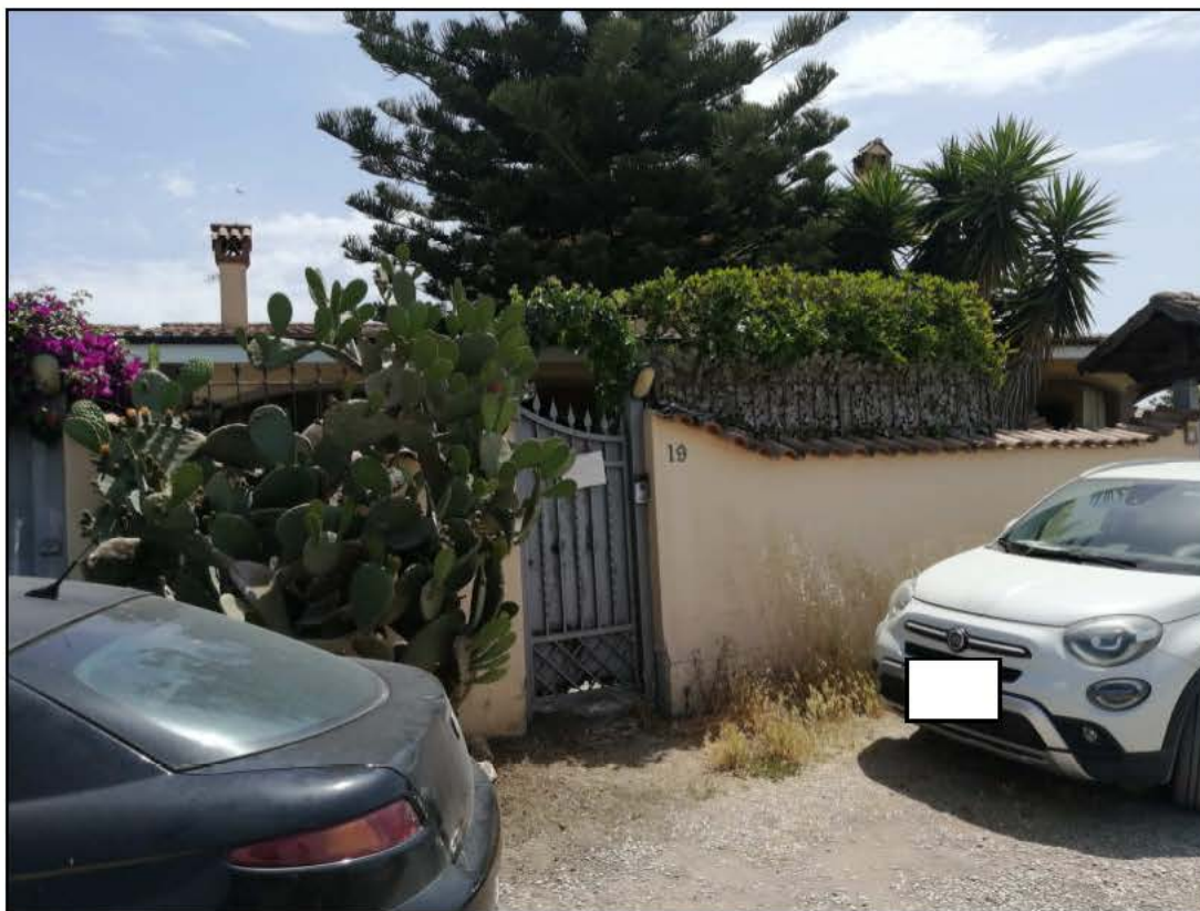
Fotografia numero 1 (uno) – Vista accesso al bene immobile in Oggetto da Via Savuto n. 19 –
