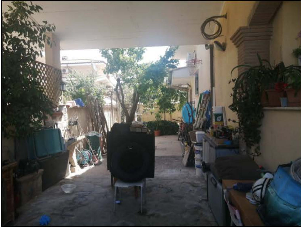
Fotografia numero 3 (tre) – Vista esterna laterale –
