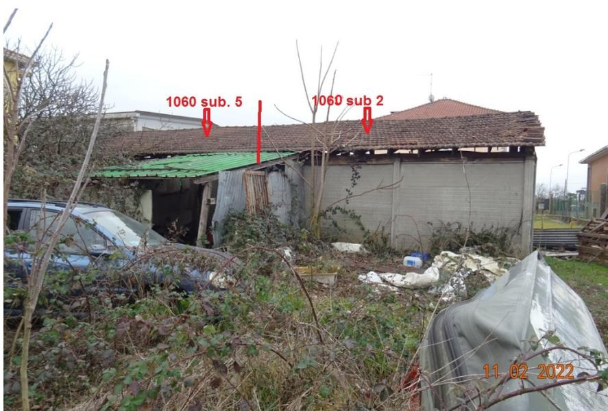
In corpo staccato, posto sul retro dell'edificio c'è un vecchio manufatto posticcio formato da pannelli e colonne prefabbricate, tetto con orditura di legno e marsigliesi. L'immobile presenta un pessimo stato di conservazione, la porzione oggetto di stima è la parte rivolta a ovest della superficie di circa 28 mq ( 7,00 x 4,00), adiacente al manufatto ci sono alcuni portici o "baracche" di lamiera posticci da demolire.
