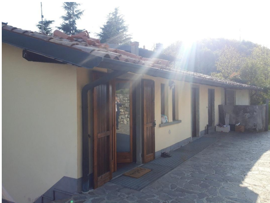
Vista ingresso lato nord 2
