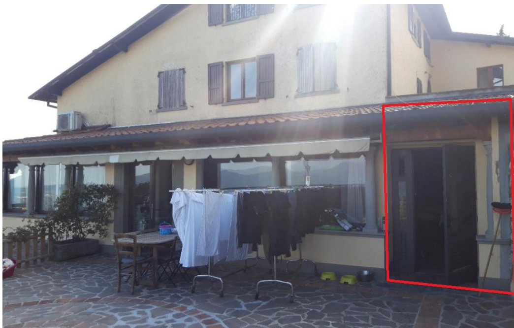
Vista esterna da est
