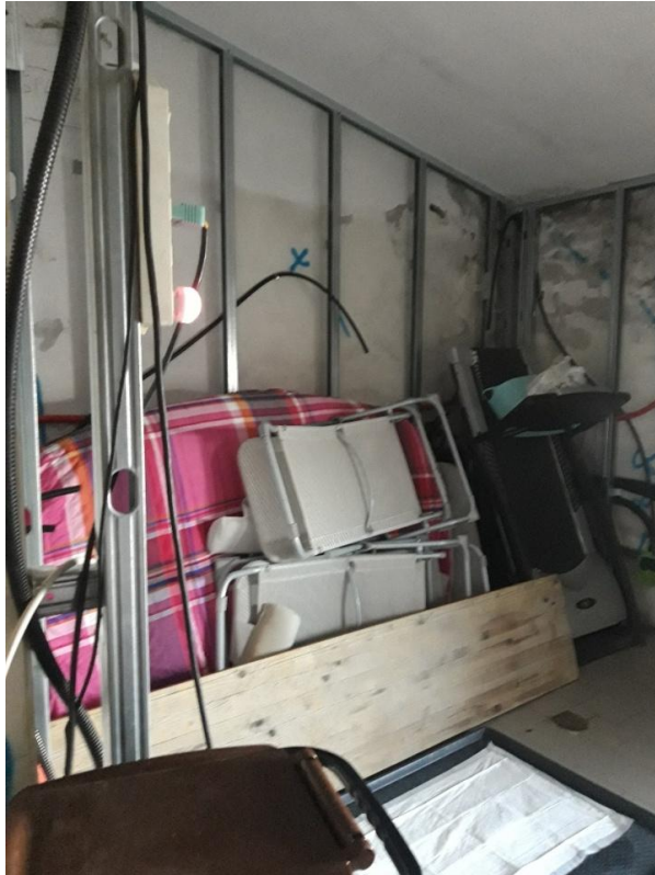
Vano 1 in fase di ristrutturazione
