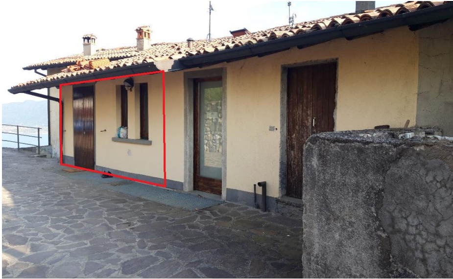
Vista ingresso lato nord 1
