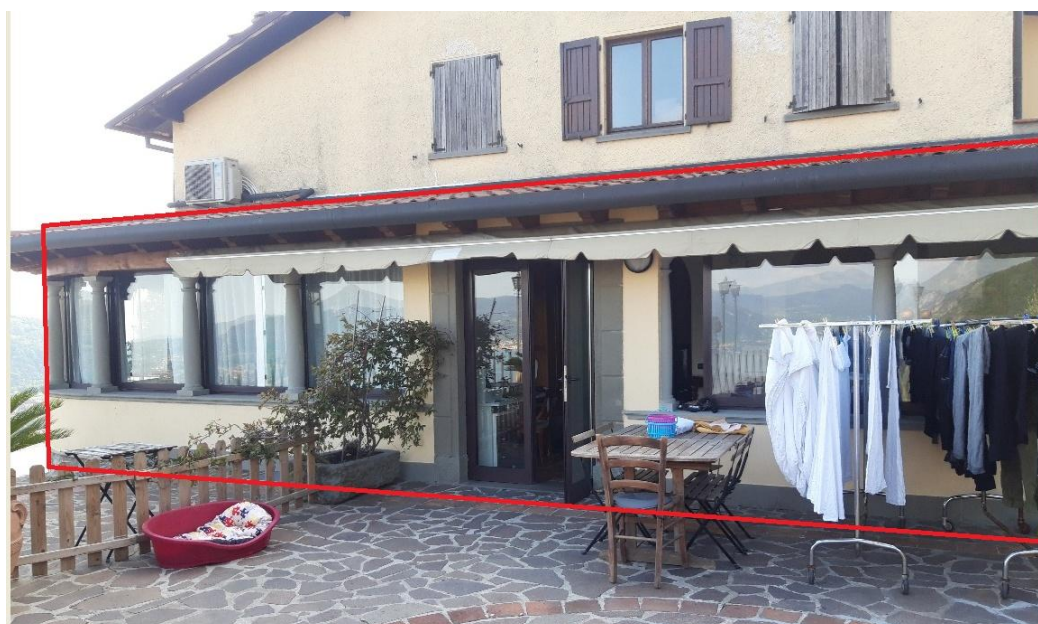
Vista esterna da est
