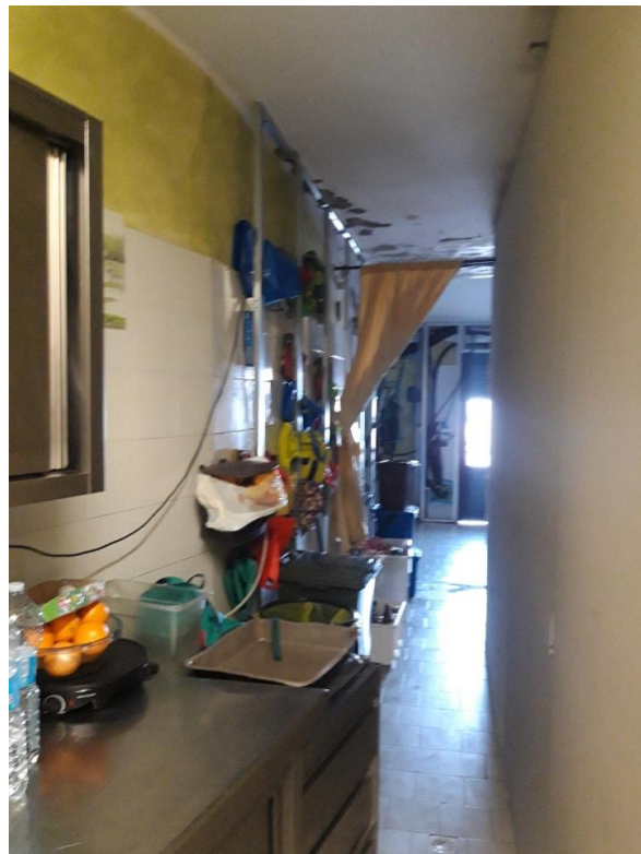
Vano 2 in fase di ristrutturazione
