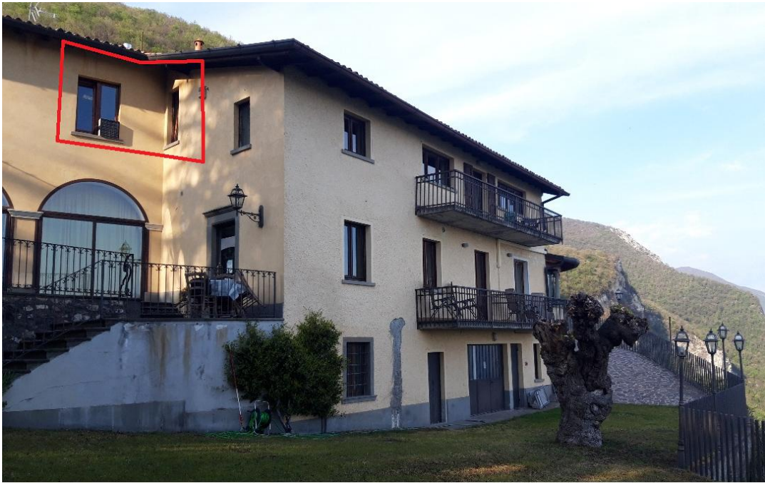
Vista immobile lato sud
