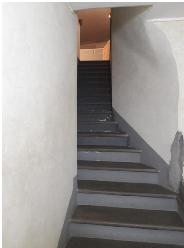
Scale con vista da piano interrato
