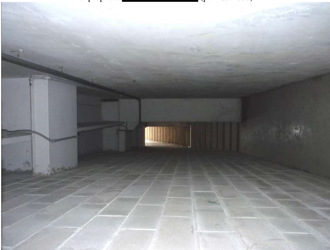
Foto alleg. n°10 – Locale ad uso scala comune (sub.93) (vista interna verso l'uscita) di proprietà [REDACTED] (per 439/1000).
