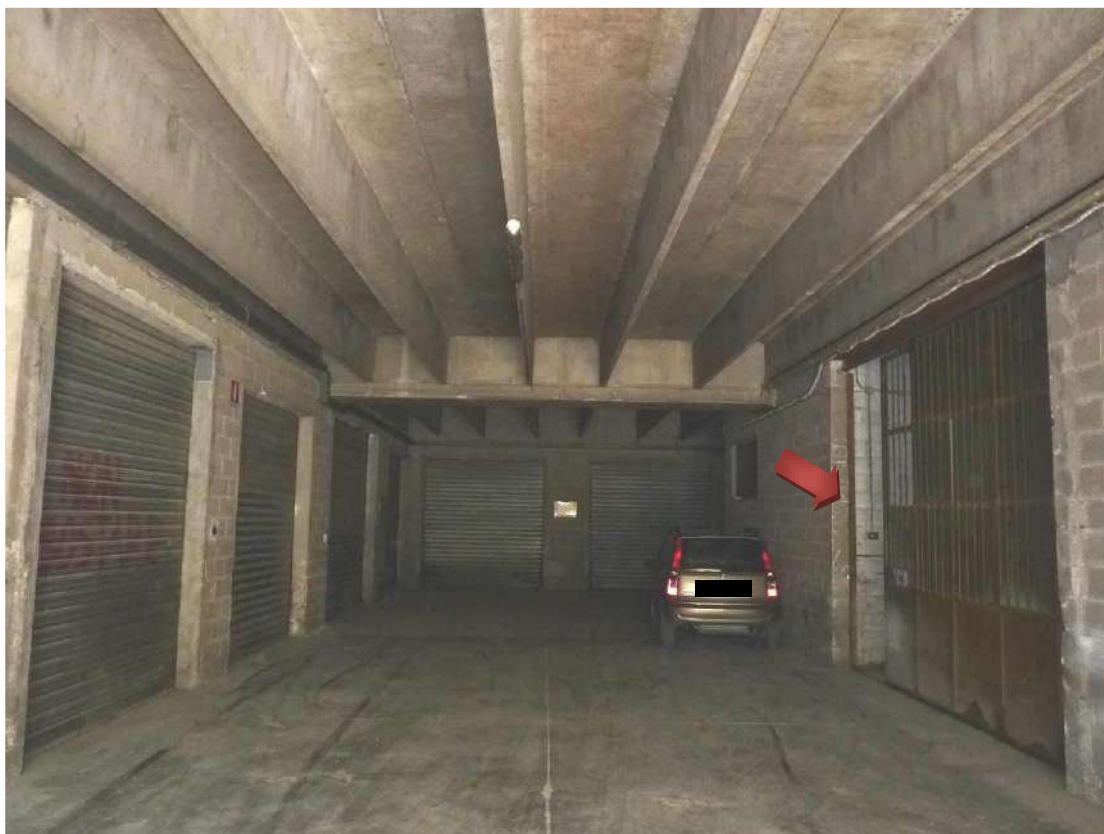
Foto alleg. n°1 – Corsello di distribuzione al piano interrato e vista del locale magazzino (sub.49) di proprietà [REDACTED]
