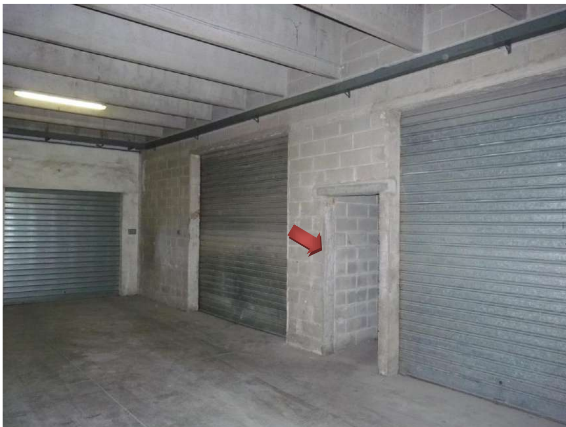
Foto alleg. n°9 – Locale ad uso scala comune (sub.93) (vista esterna dal corridoio comune) di proprietà [REDACTED] (per 439/1000).
