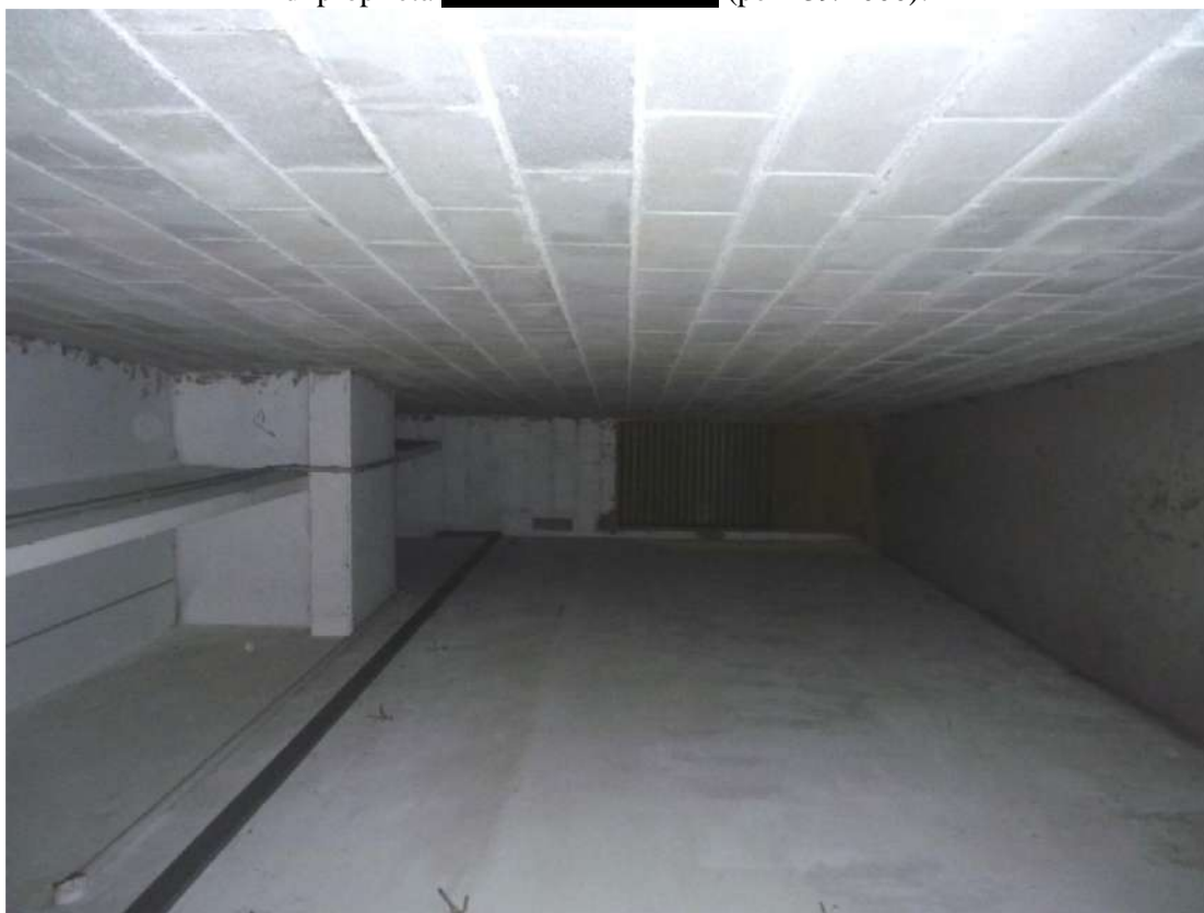
Foto alleg. n°12 – Locale ad uso scala comune (sub.93) (vista interna verso l'ingresso) di proprietà [REDACTED] (per 439/1000).
