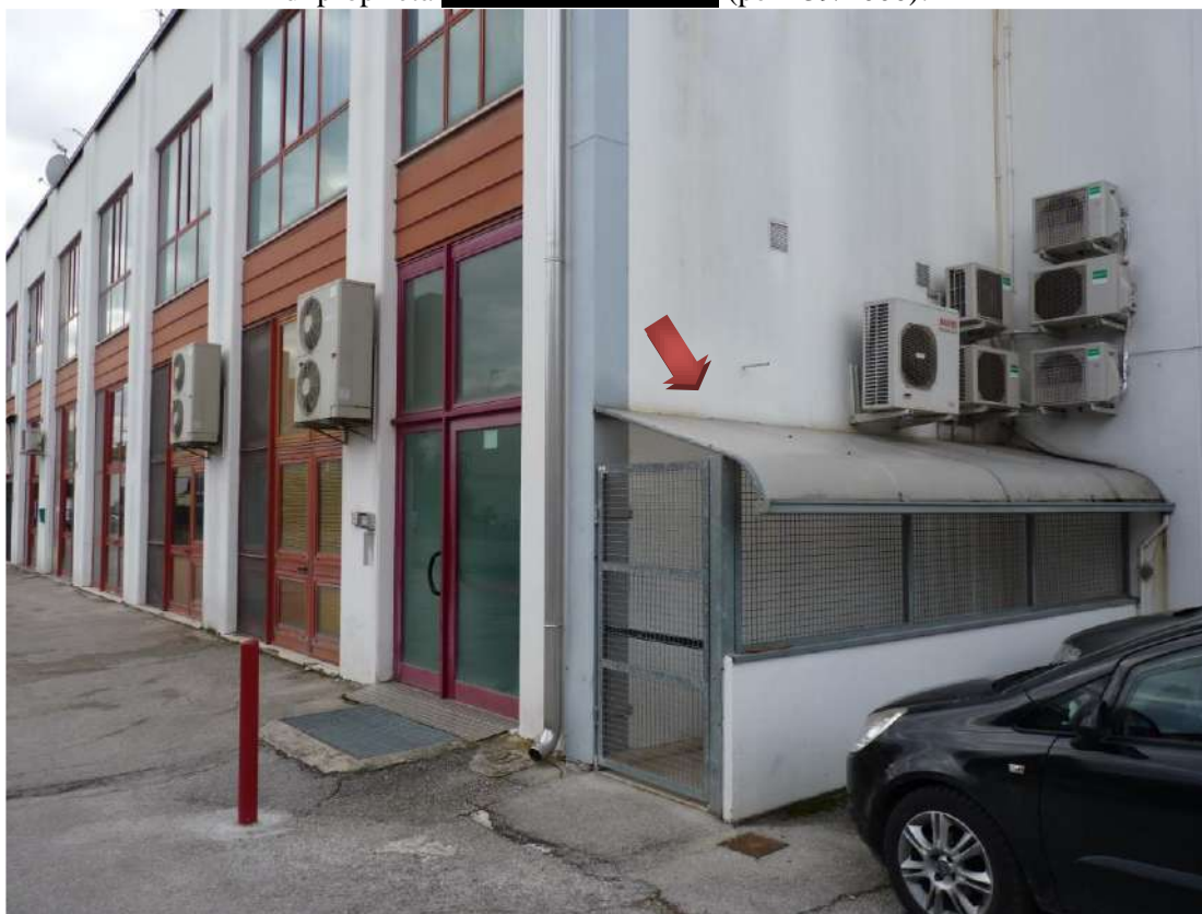
Foto alleg. n°14 – Locale ad uso scala comune (sub.93) (vista esterna lato piazzale esterno) di proprietà [REDACTED] (per 439/1000).
