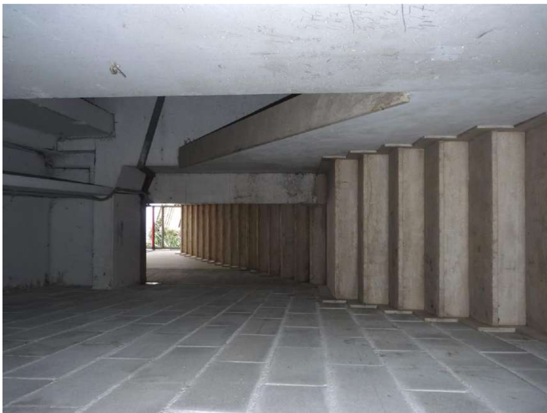
Foto alleg. n°11 – Locale ad uso scala comune (sub.93) (vista interna verso l'uscita) di proprietà [REDACTED] (per 439/1000).
