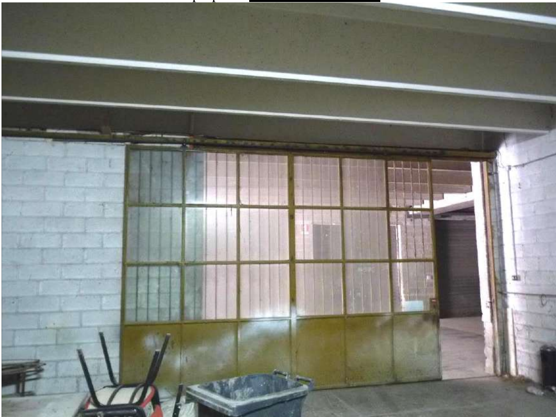
Foto alleg. n°8 – Locale magazzino (sub.49) (vista interna zona di ingresso) di proprietà [REDACTED]
