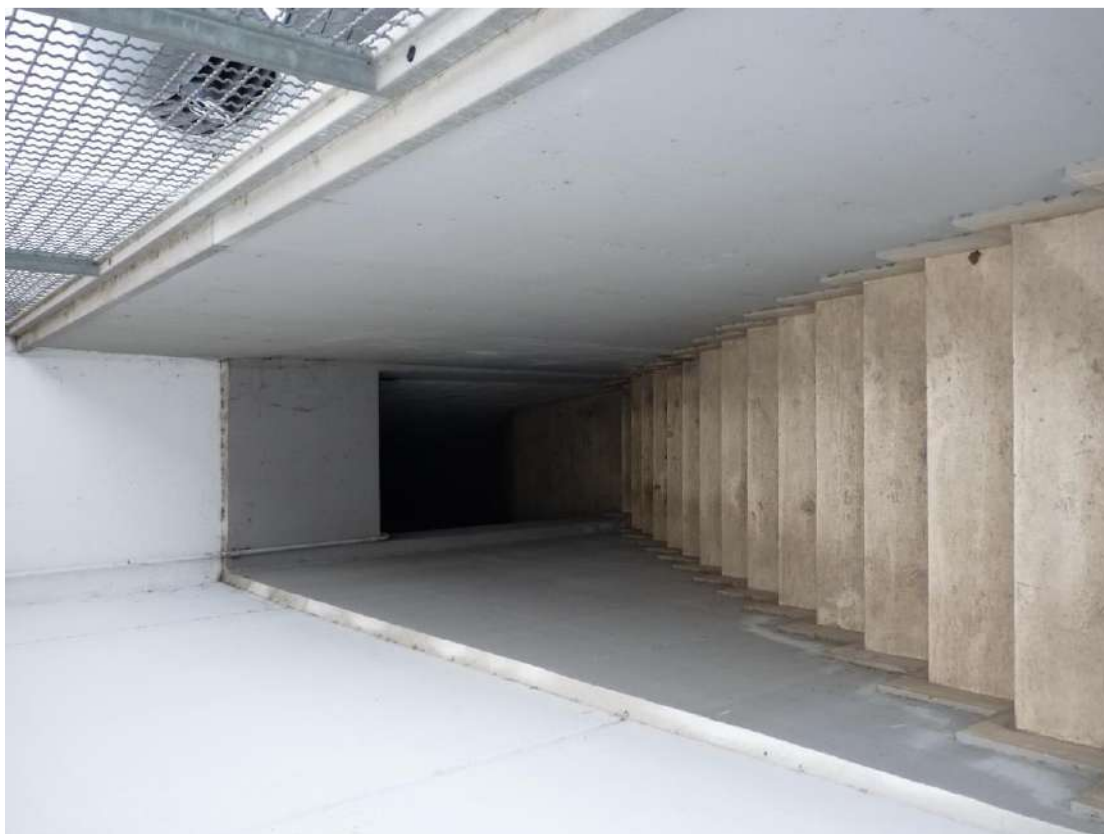
Foto alleg. n°13 – Locale ad uso scala comune (sub.93) (vista della rampa zona uscita) di proprietà [REDACTED] (per 439/1000).
