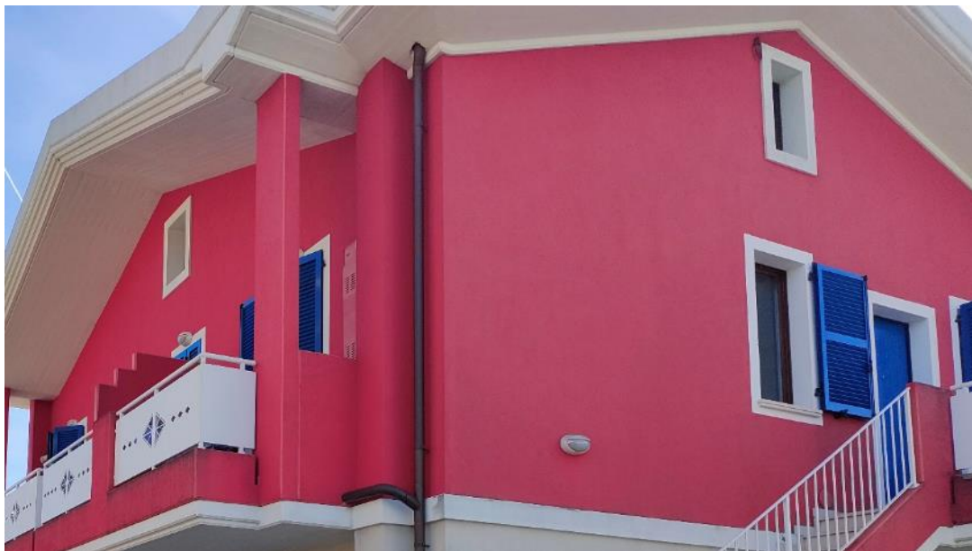
Vista fronte e lato loggia
