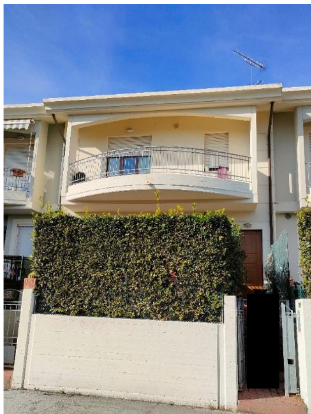
Vista sul fronte
