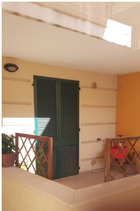
Scoperto sul fronte
