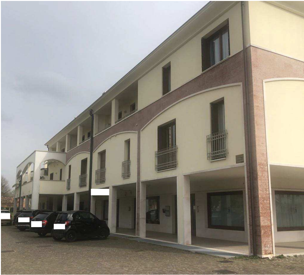
Facciata nord del fabbricato
