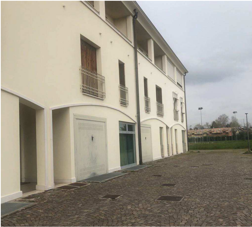
Facciata sud del fabbricato
