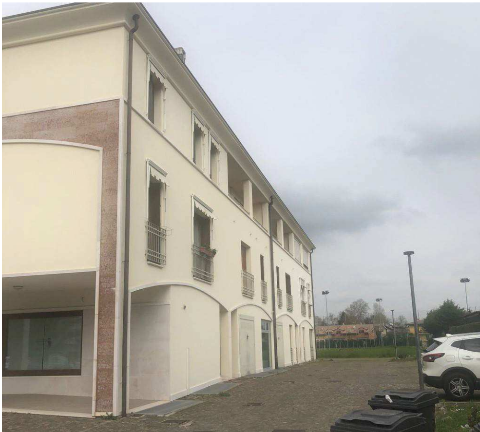
Facciata sud – angolo sud-ovest ovest del fabbricato
