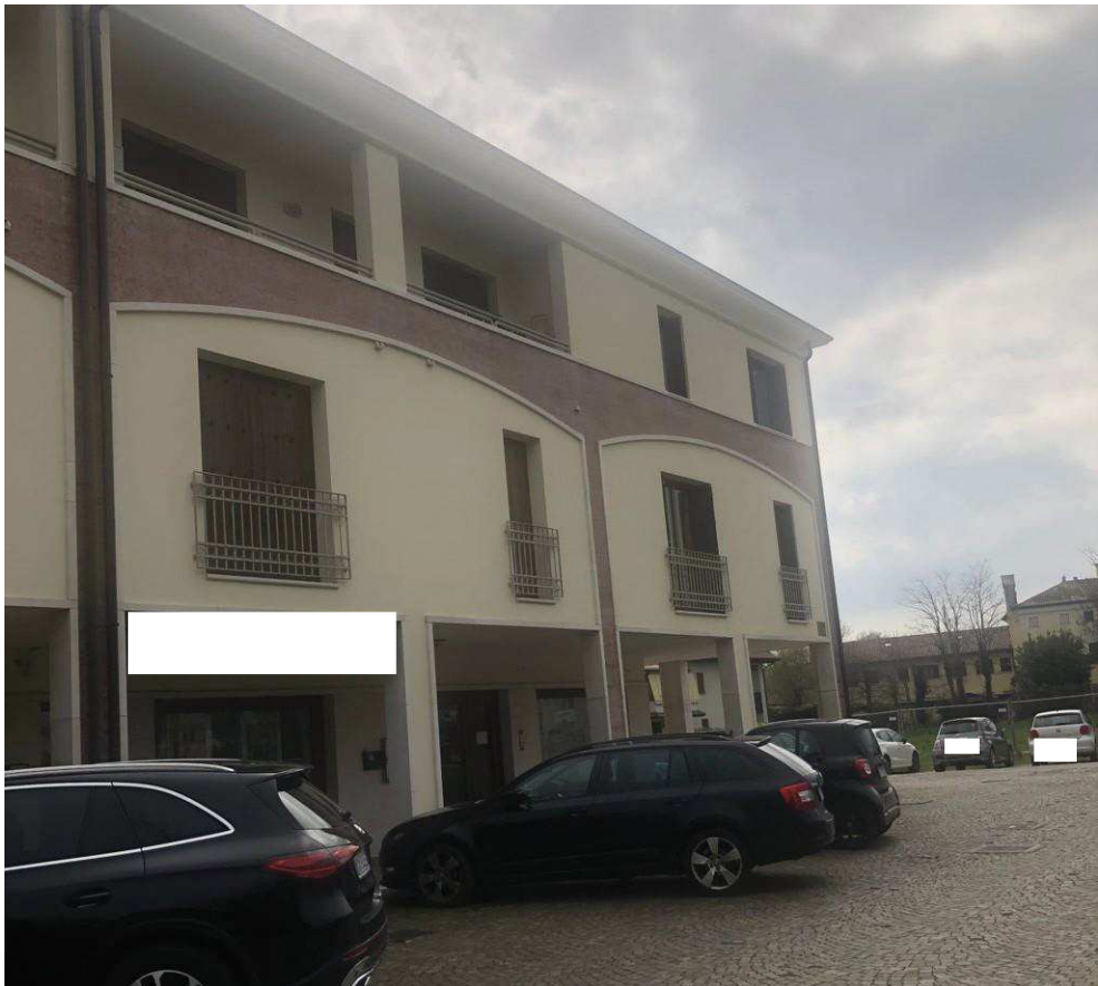
Facciata nord del fabbricato
