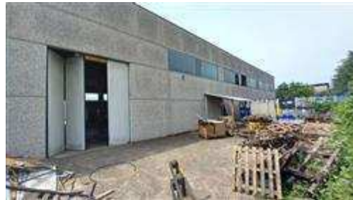
Prospetto lato nord con piazzale posteriore e portone
