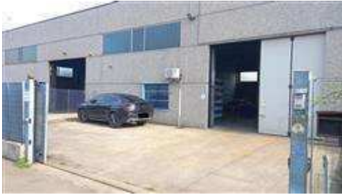
Piazzale esterno di accesso al capannone
