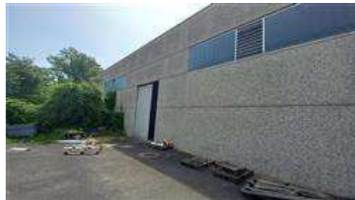
Prospetto lato nord con piazzale posteriore
