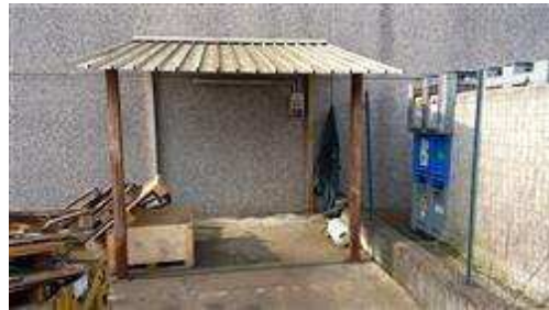
Tettoia nel piazzale posteriore
