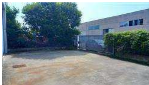
Cancello scorrevole di ingresso su piazzale scoperto anteriore
