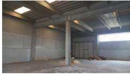
Particolare interno con portone principale di accesso
