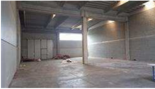
Particolare interno con portone principale di accesso
