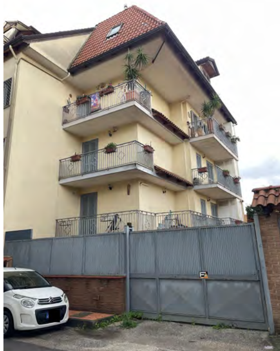
Fotografia n. 3 _ Prospetto del fabbricato su via Giuseppe Cesare Abba – L' ingresso carrabile nella foto non è pertinenziale al LOTTO UNICO
