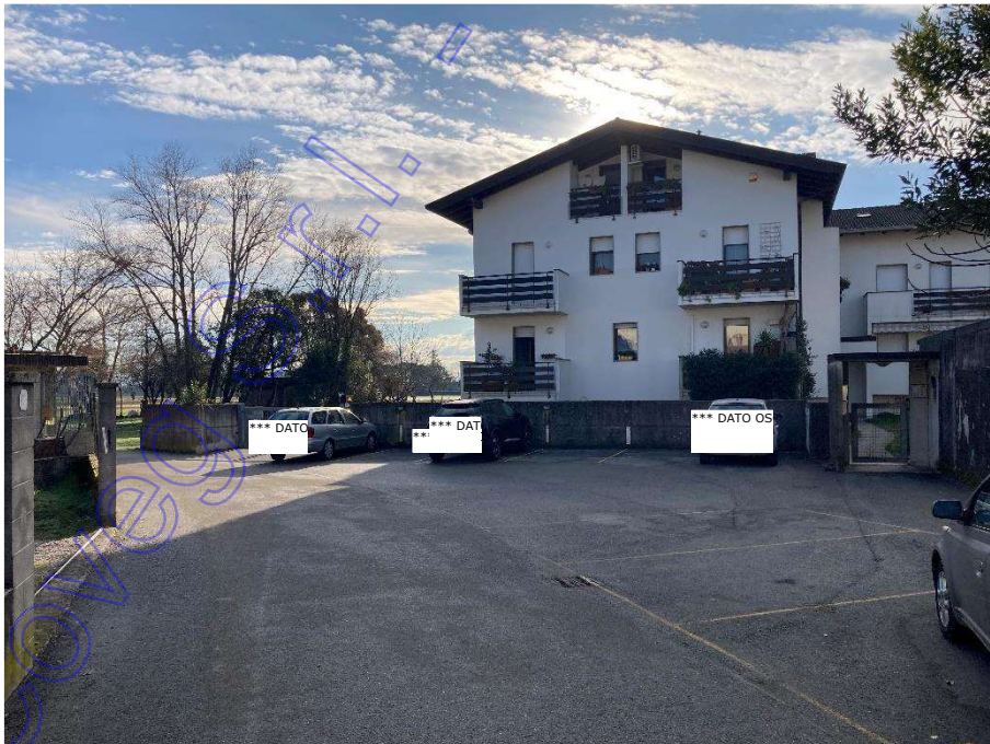
Vista esterna condominio – acceso pedonale e area parcheggio esterna
