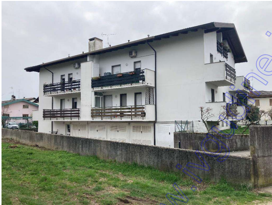
Vista esterna condominio
