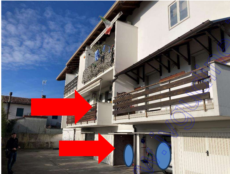
Vista esterna del garage e dell'appartamento
