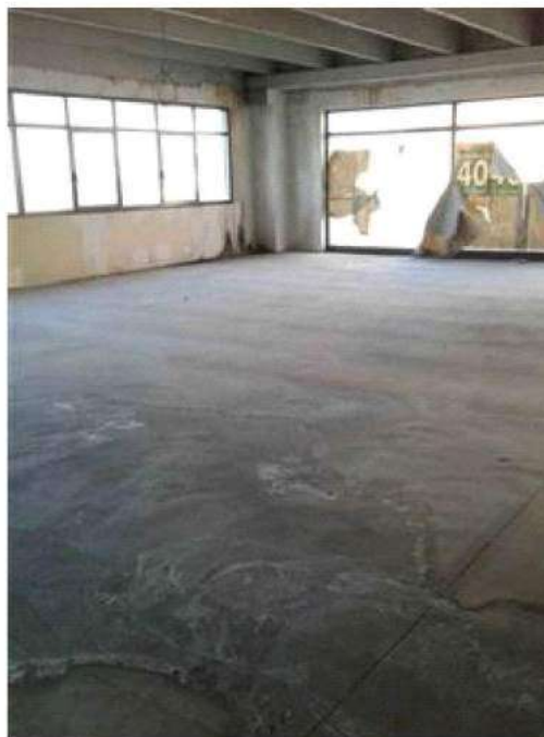
Vista interna (stato manutentivo)
