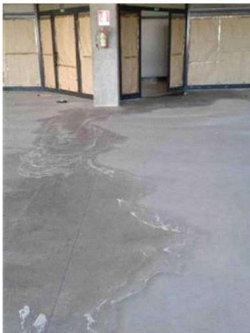
Vista interna (stato manutentivo)
