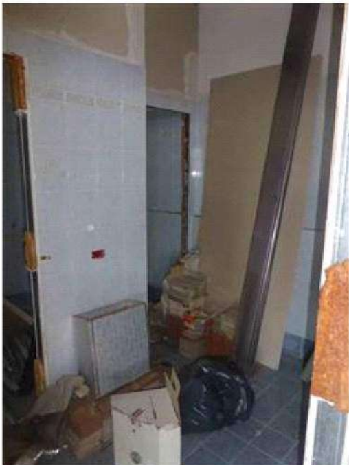
Vista interna (bagni)
