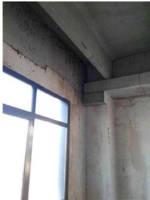
Vista interna (stato manutentivo)
