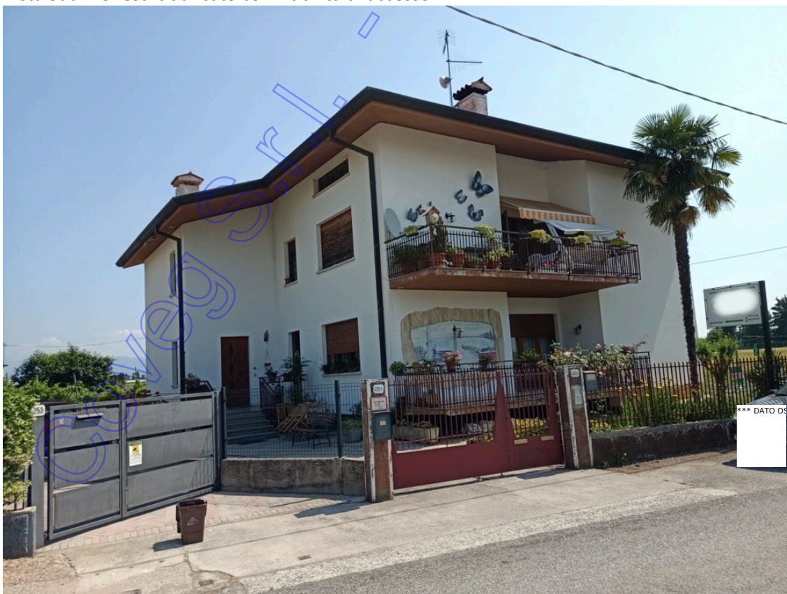
Vista Sud – Ovest fabbricato con viabilità di accesso
