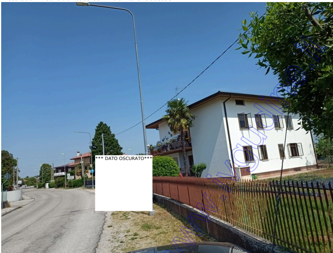
Vista Sud – Est fabbricato con viabilità di accesso
