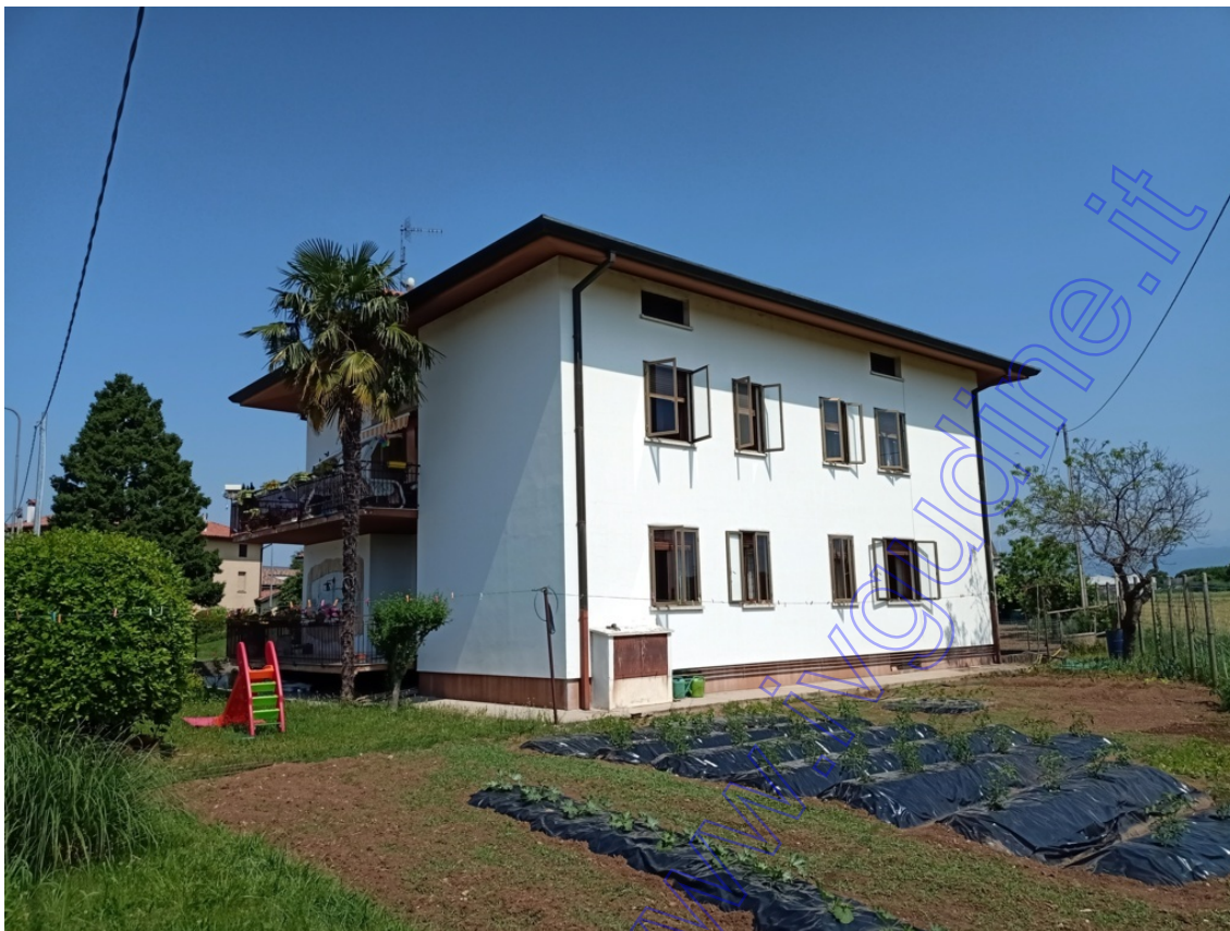
Vista Sud – Est fabbricato
