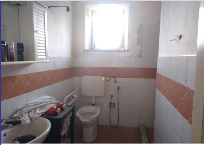
Foto 34 - Particolare del bagno al piano 1°.
