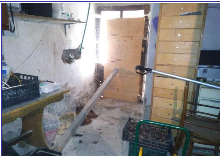
Foto 8 e 9 - Il piano terra ha un'altezza interna variabile tra 1,90 e 2,50 m. La struttura è in muratura di pietra e solai in laterizio con travi in legno.
