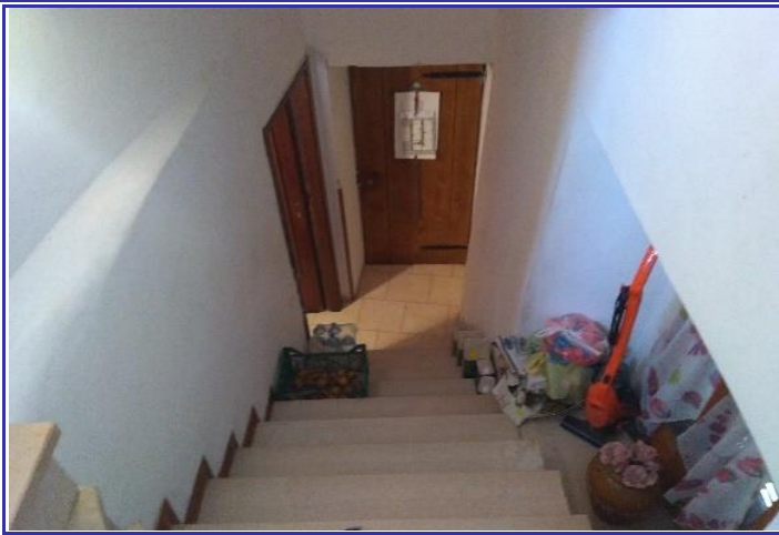
Foto 16 - La scala di accesso al piano 2°.
