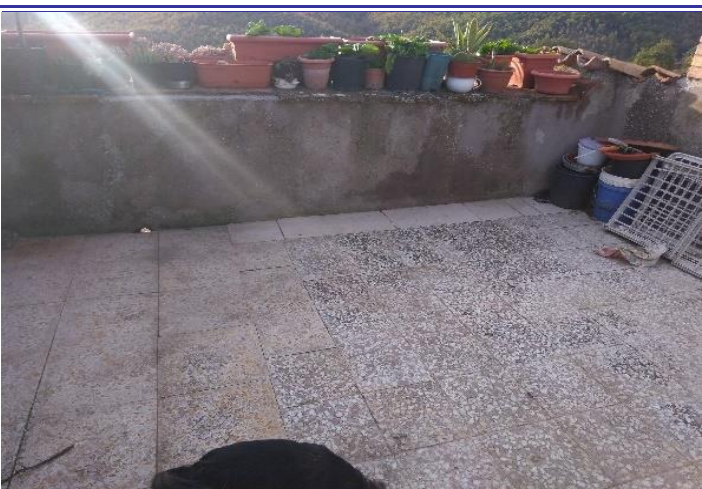
Foto 20 - Altra vista della terrazza.
