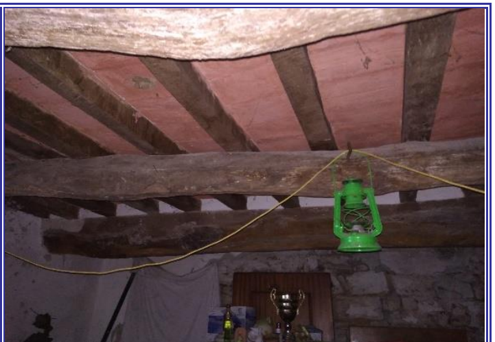
Foto 8 e 9 - Il piano terra ha un'altezza interna variabile tra 1,90 e 2,50 m. La struttura è in muratura di pietra e solai in laterizio con travi in legno.
