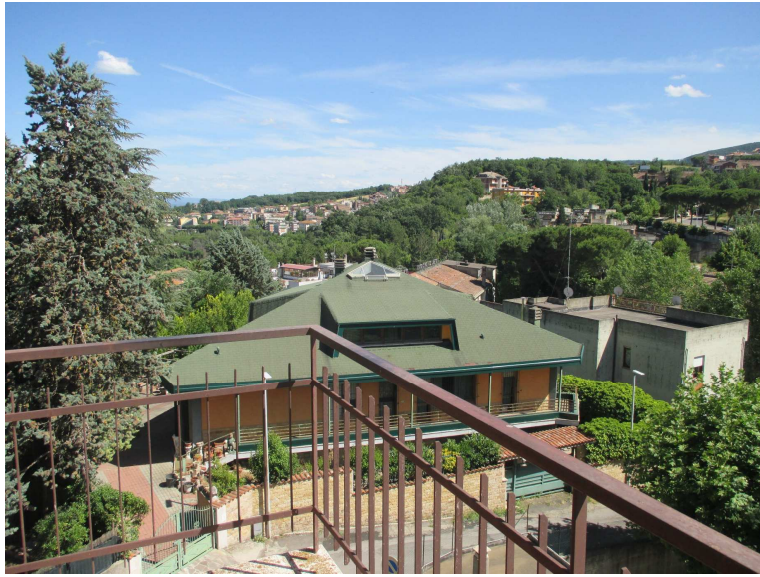
foto 19 – Vista verso Strada Ingresso.
