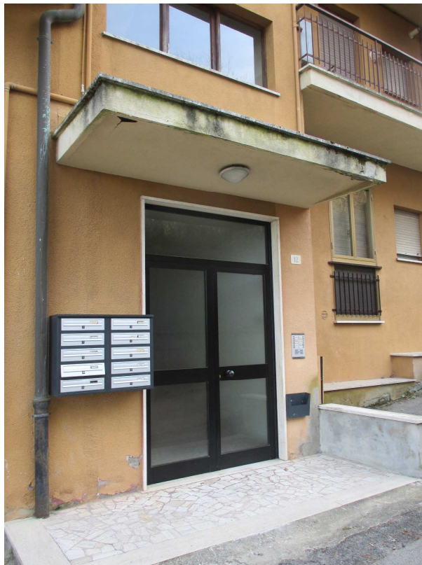
foto 2 – Vista Ingresso Vano Scala Condominiale.
