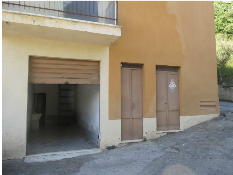
foto 27 – Particolare Ingresso Garage da resede.
