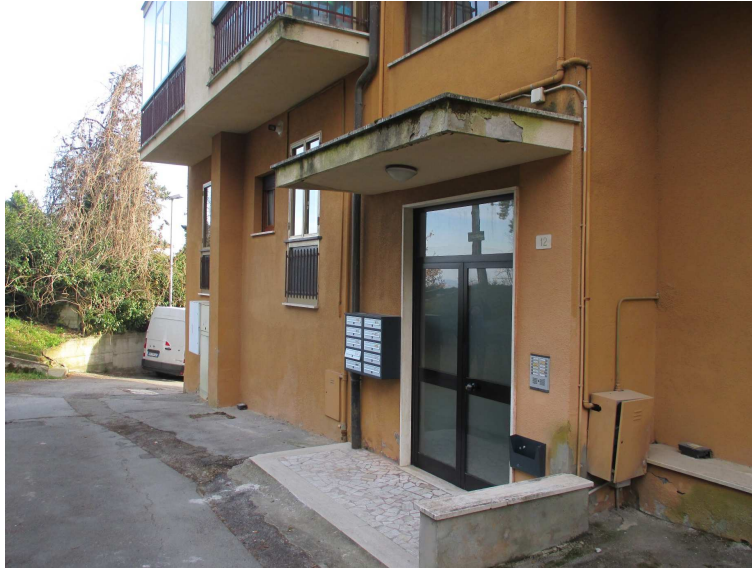
foto 1 – Vista Proprietà Ingresso Condominiale Appartamento da Resede.
