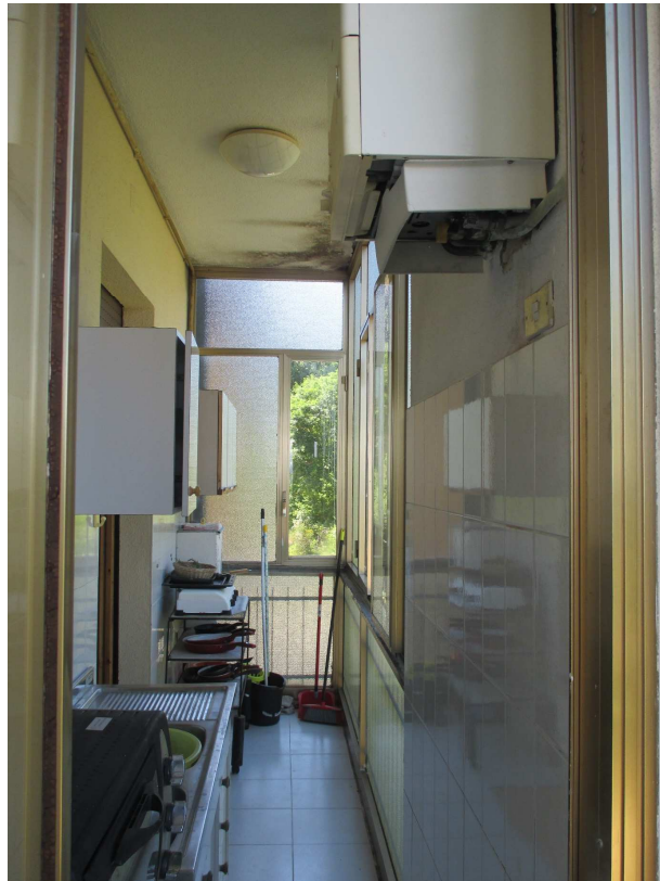
foto 25 – Particolare zona Veranda e caldaia.
