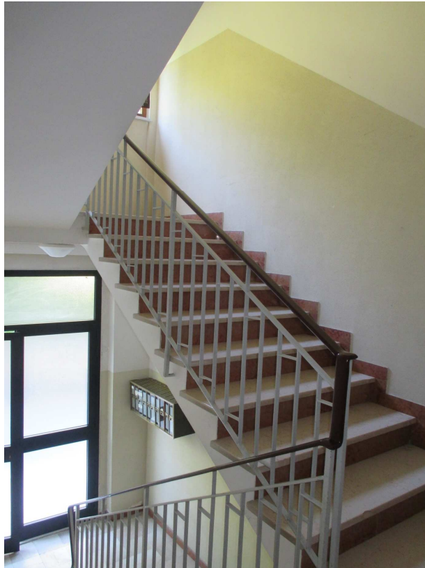
foto 5 – Vista Interno Ingresso Condominiale.
