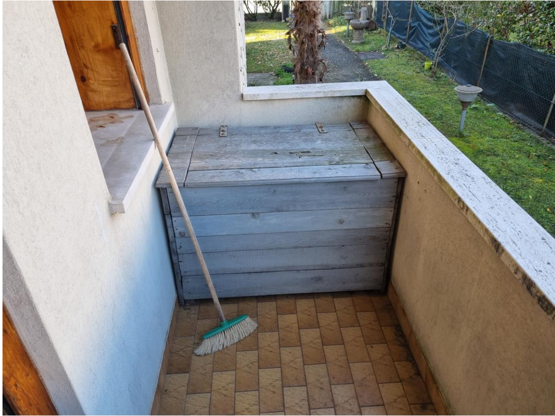
VISTA ESTERNA - TERRAZZO
