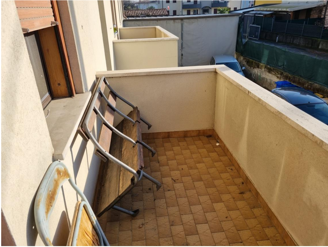
VISTA ESTERNA - TERRAZZO
