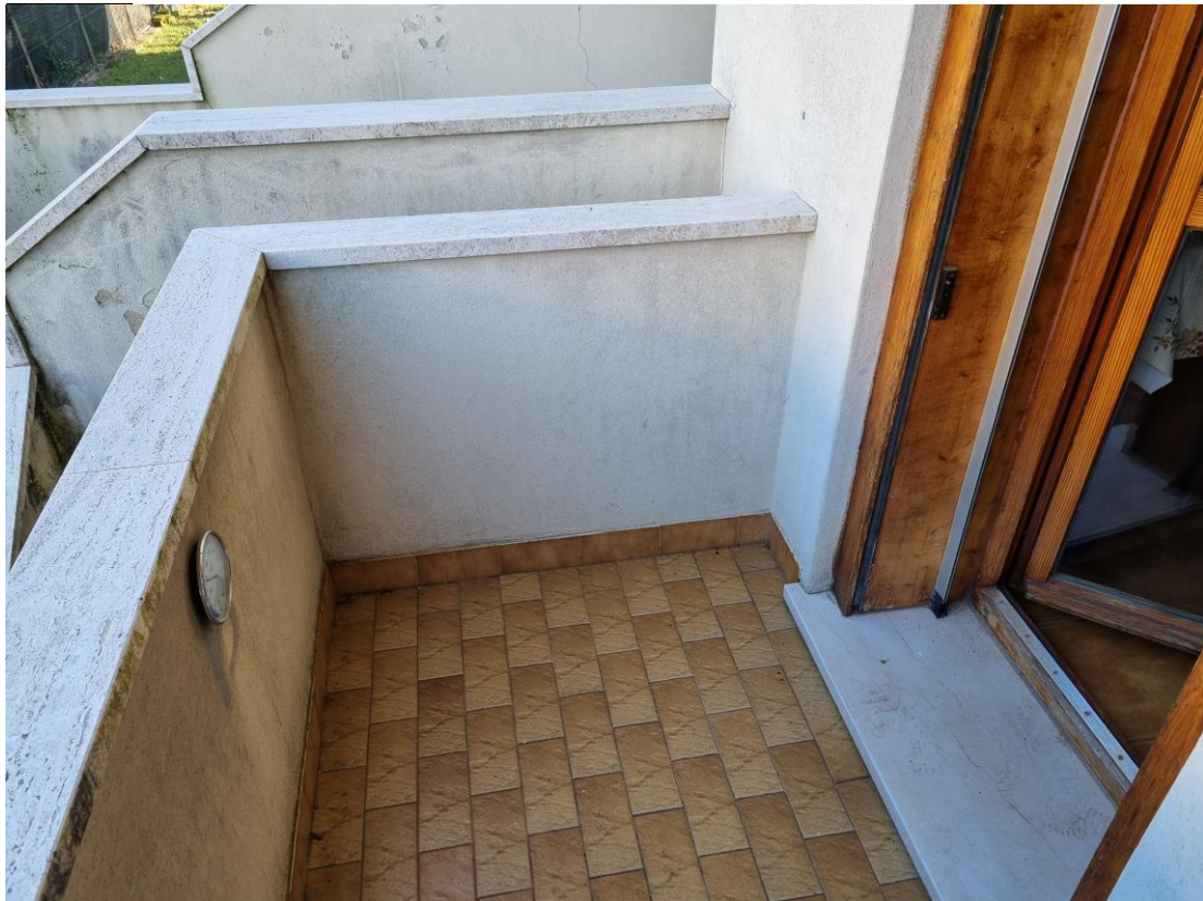
VISTA ESTERNA - TERRAZZO
