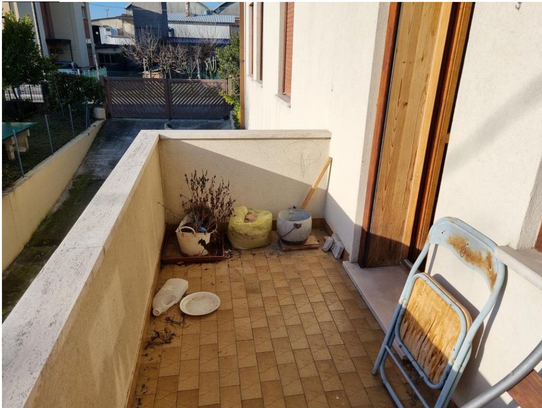
VISTA ESTERNA - TERRAZZO
