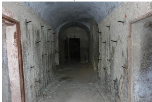
Vano 1 - Ingr./Vano scala
