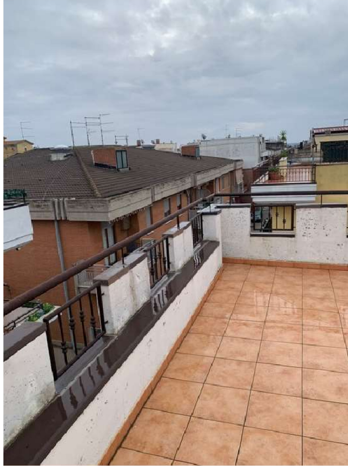
Foto 25 – APPARTAMENTO – San Severo, Via Deliceto,1/DA (foglio 79 particella 1336 subalterno 81)
