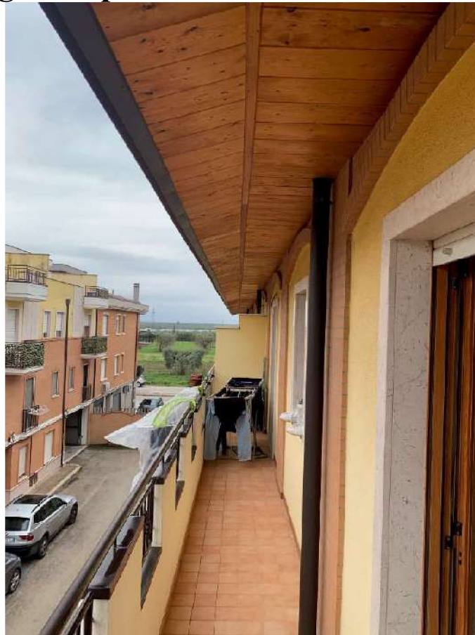
Foto 14 – APPARTAMENTO – San Severo, Via Deliceto,1/DA (foglio 79 particella 1336 subalterno 81)
