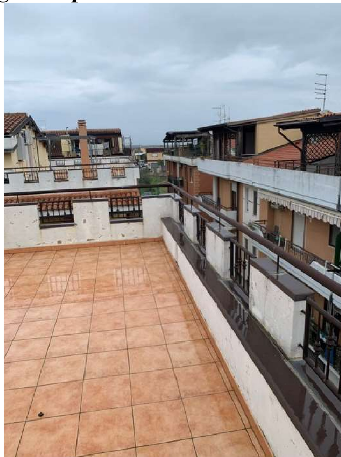
Foto 24– APPARTAMENTO – San Severo, Via Deliceto,1/DA (foglio 79 particella 1336 subalterno 81)
