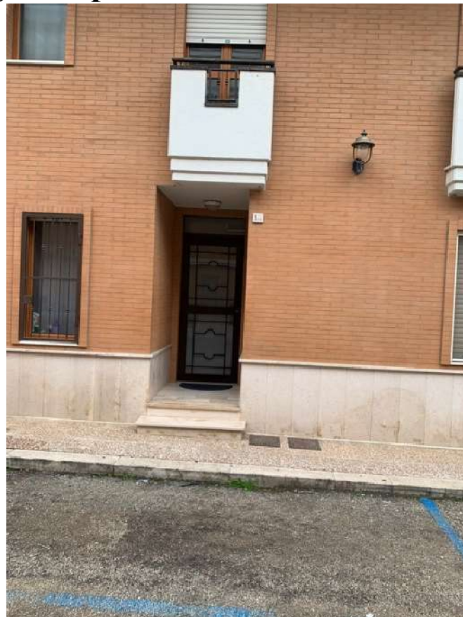
Foto 4 – APPARTAMENTO – San Severo, Via Deliceto, 1/DA (foglio 79 particella 1336 subalterno 81)
