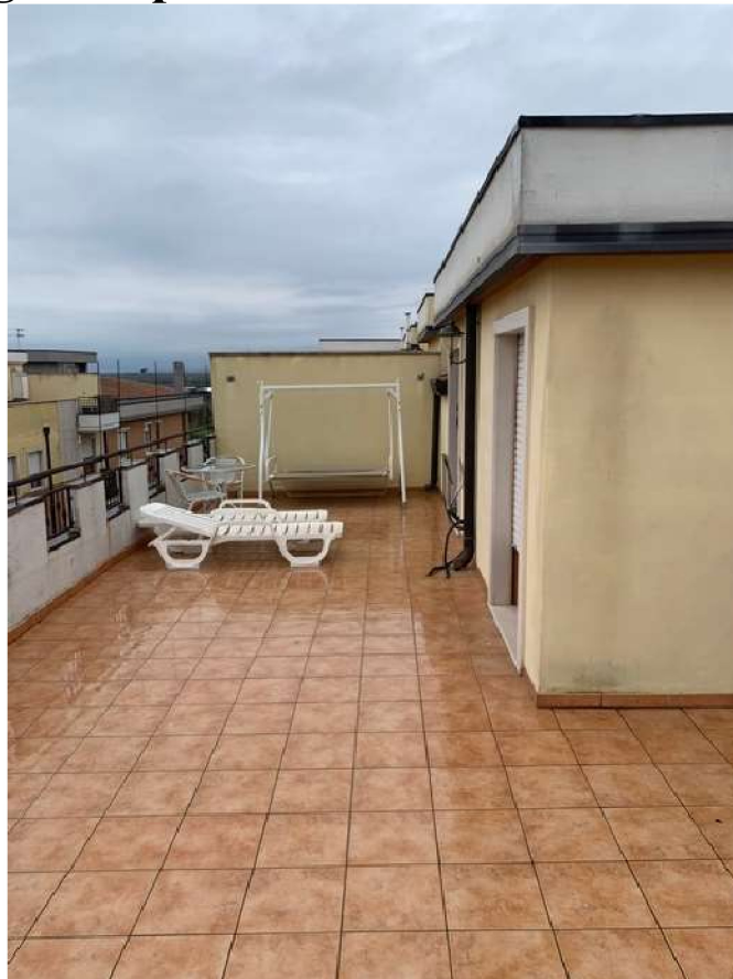
Foto 26 – APPARTAMENTO – San Severo, Via Deliceto,1/DA (foglio 79 particella 1336 subalterno 81)
