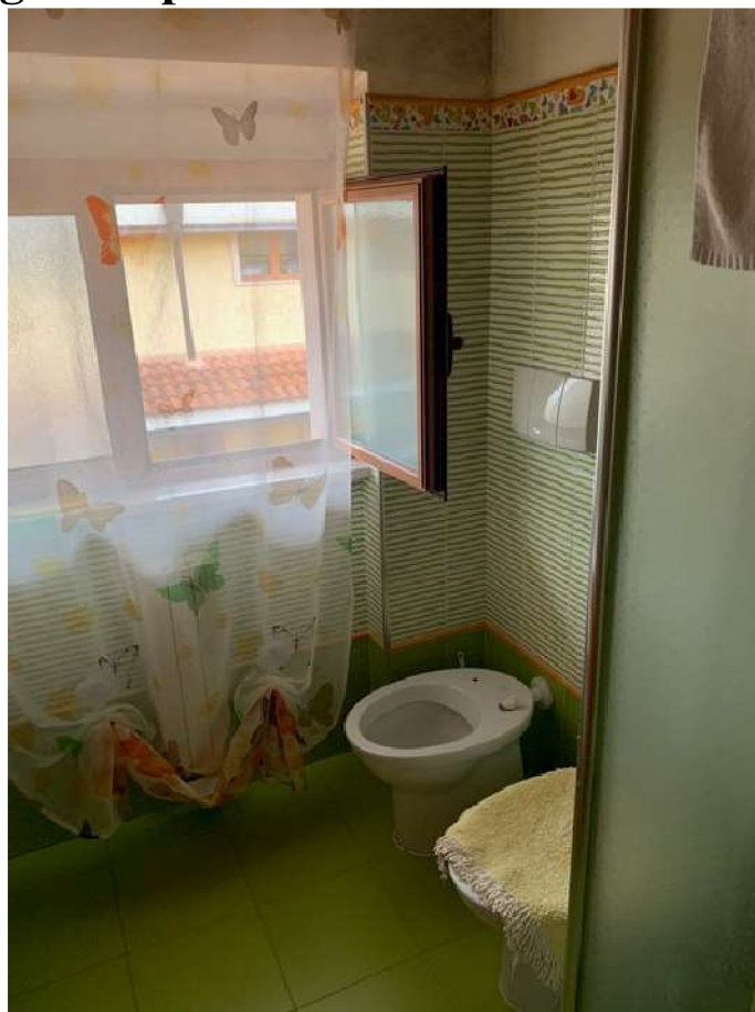
Foto 19 – APPARTAMENTO – San Severo, Via Deliceto,1/DA (foglio 79 particella 1336 subalterno 81)
