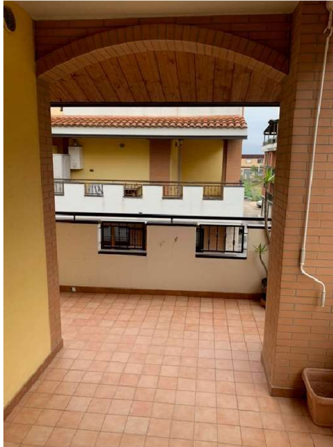
Foto 13 – APPARTAMENTO – San Severo, Via Deliceto,1/DA (foglio 79 particella 1336 subalterno 81)
