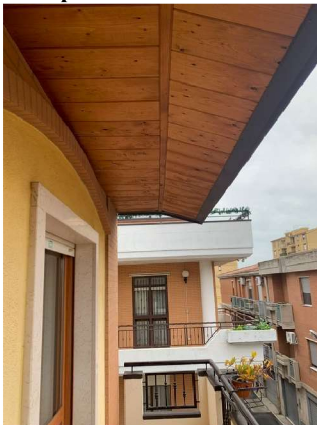
Foto 15 – APPARTAMENTO – San Severo, Via Deliceto,1/DA (foglio 79 particella 1336 subalterno 81)
