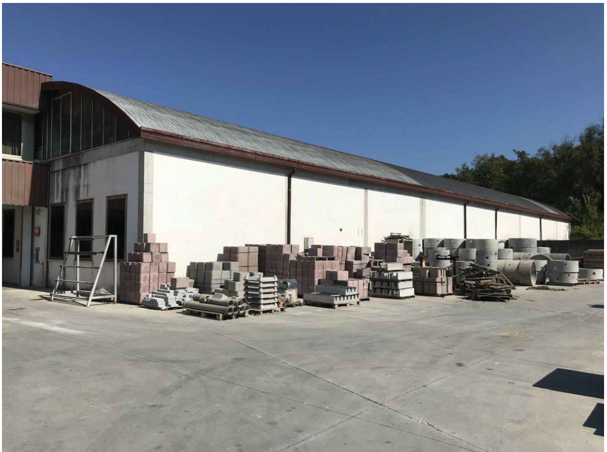
FOTO 5 - lato sud stabilimento
