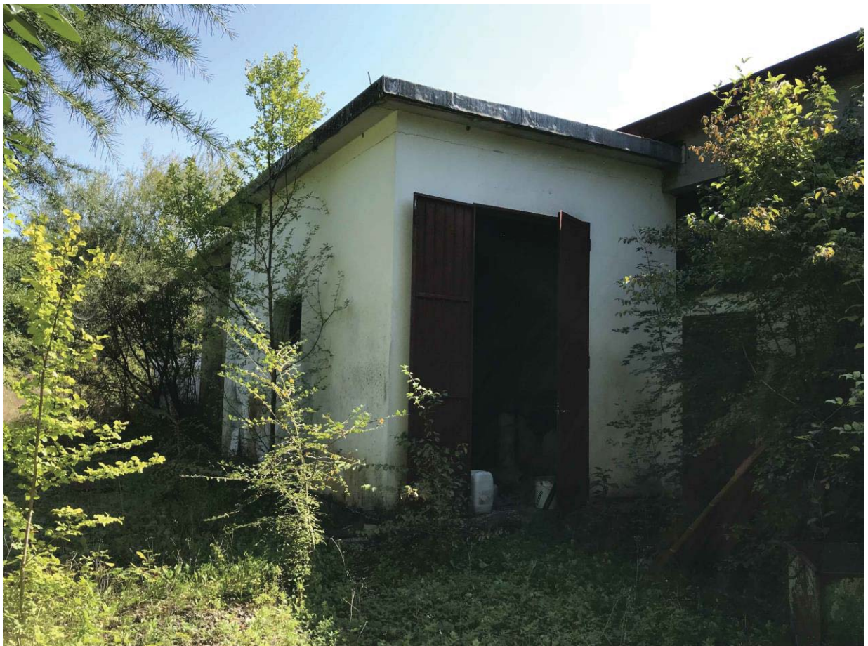
FOTO 11 – locali tecnici lato nord
