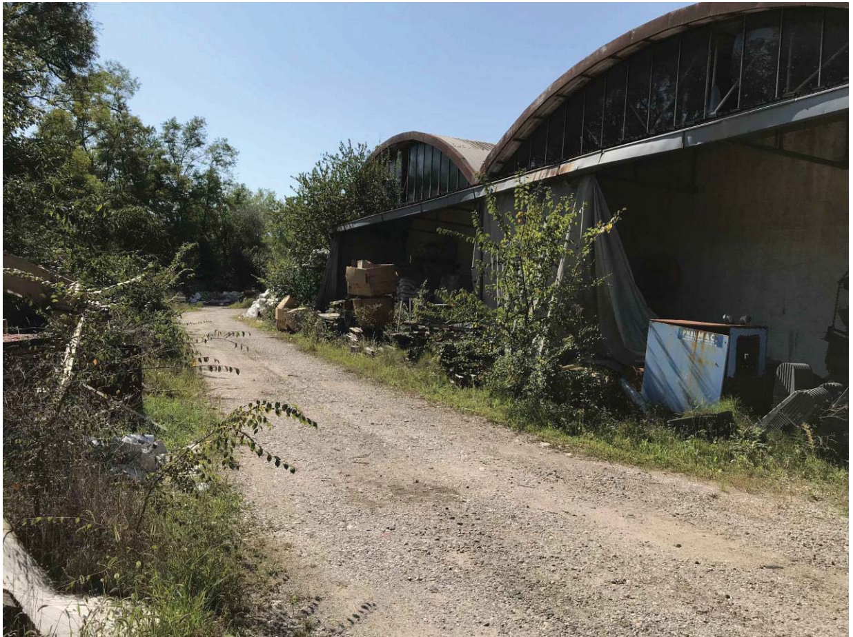
FOTO 8 - tettoia lato est
