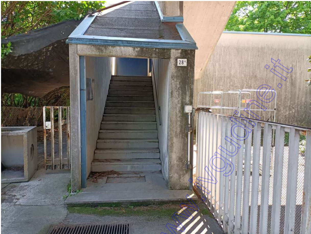
scala di accesso all'appartamento custode (primo piano)
