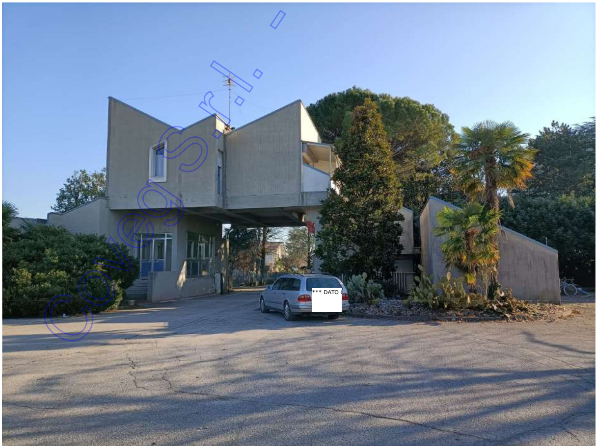
veduta dal piazzale interno
