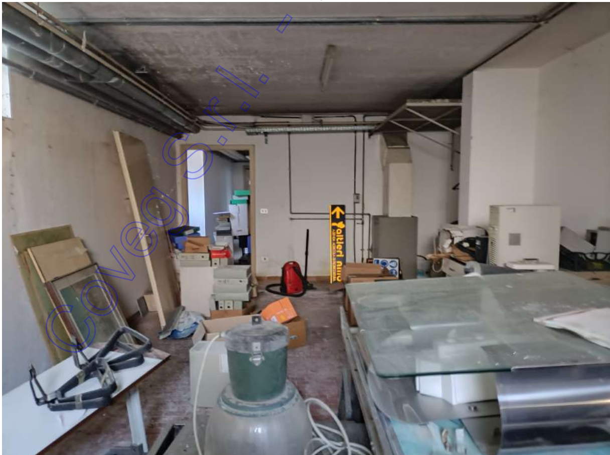
interno uffici: piano scantinato
