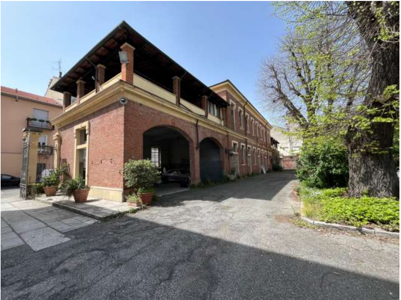
Interno corte – Palazzina F3 in corso di costruzione
