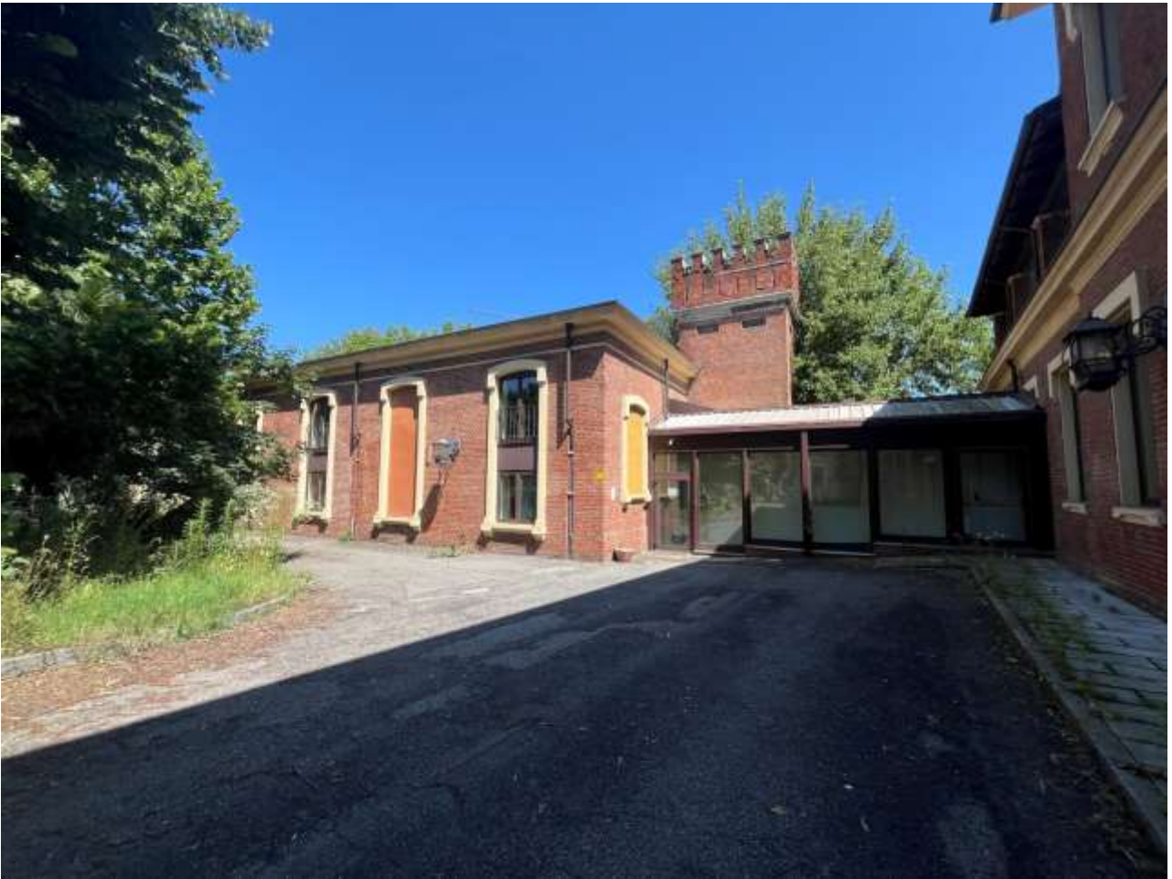
Interno corte – Palazzina C
