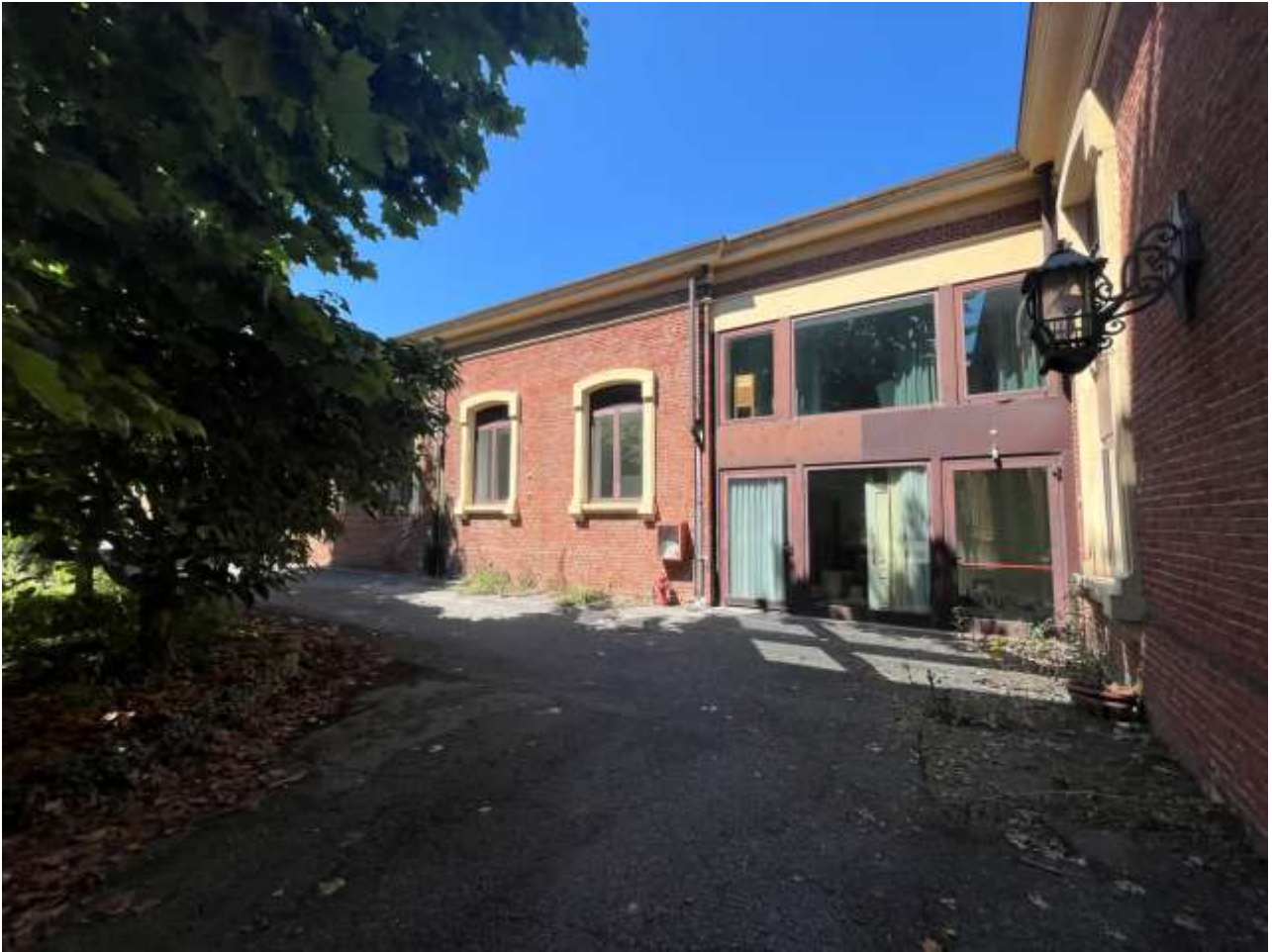
Interno corte – Palazzina C/D
