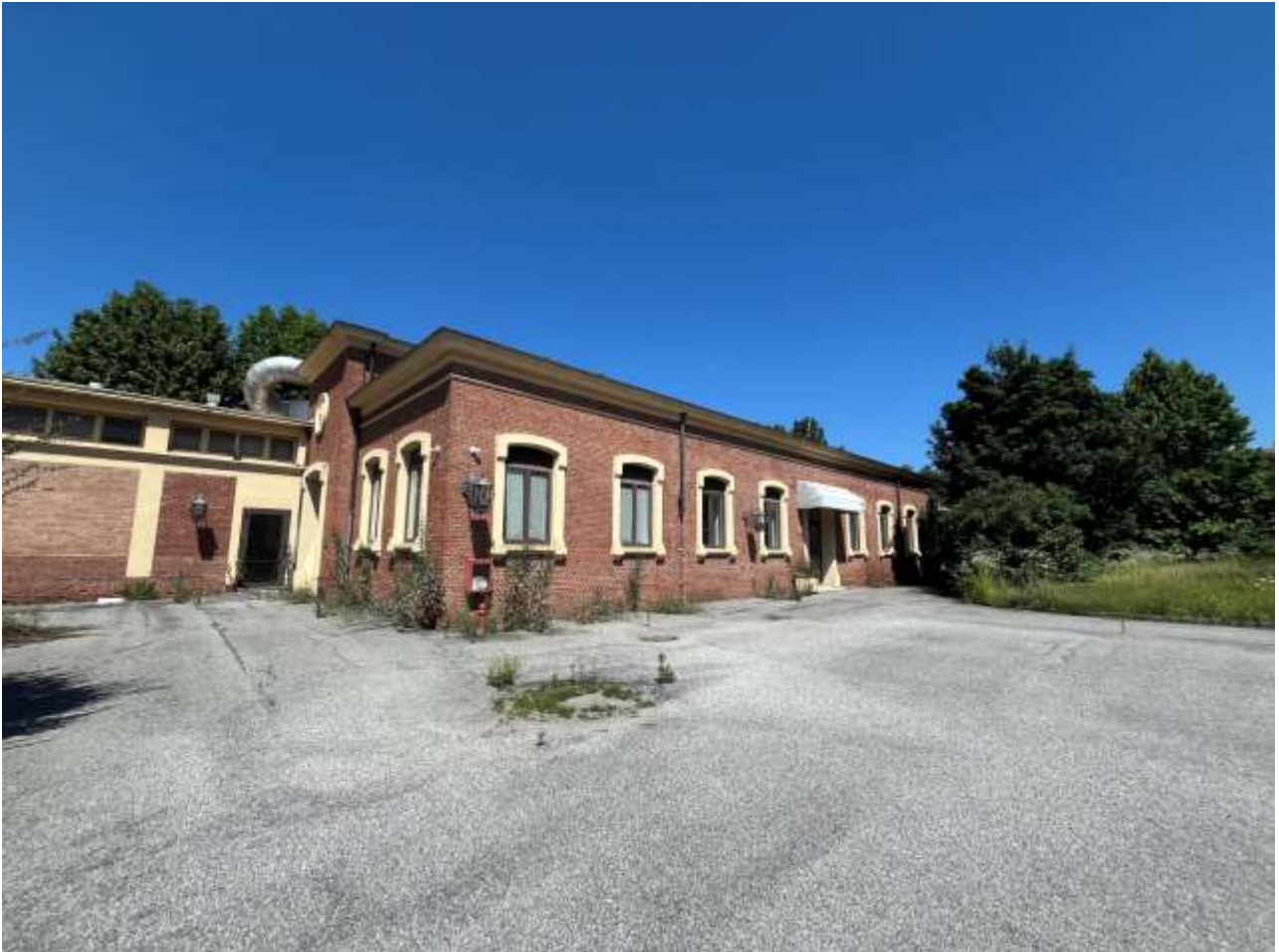
Interno corte – Palazzina D
