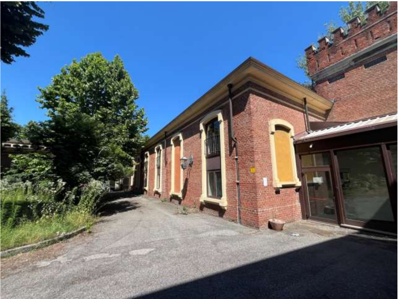
Interno corte – Palazzina C
