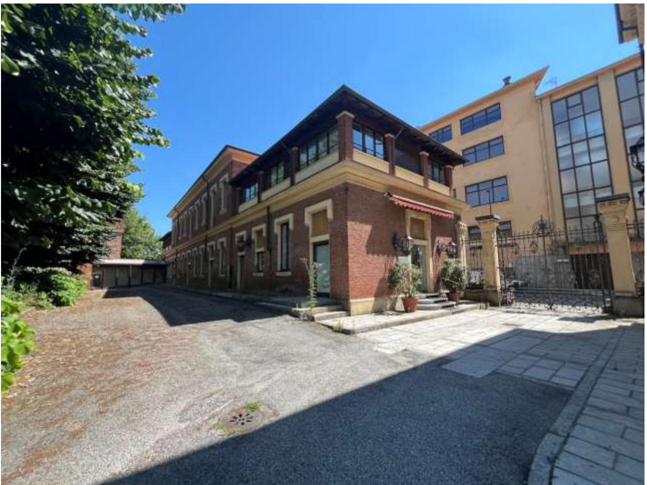
Interno corte – Palazzina B
