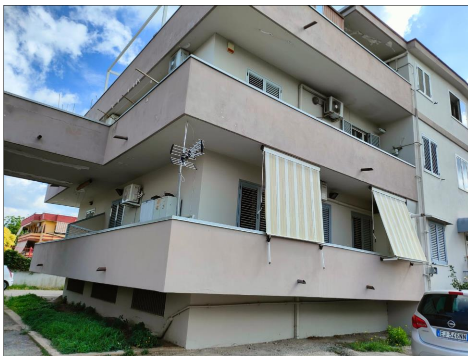
Facciata esterna fabbricato
