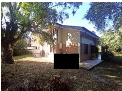
vista prospetto posteriore
