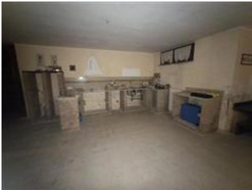
locale al piano interrato destinato a cantina
