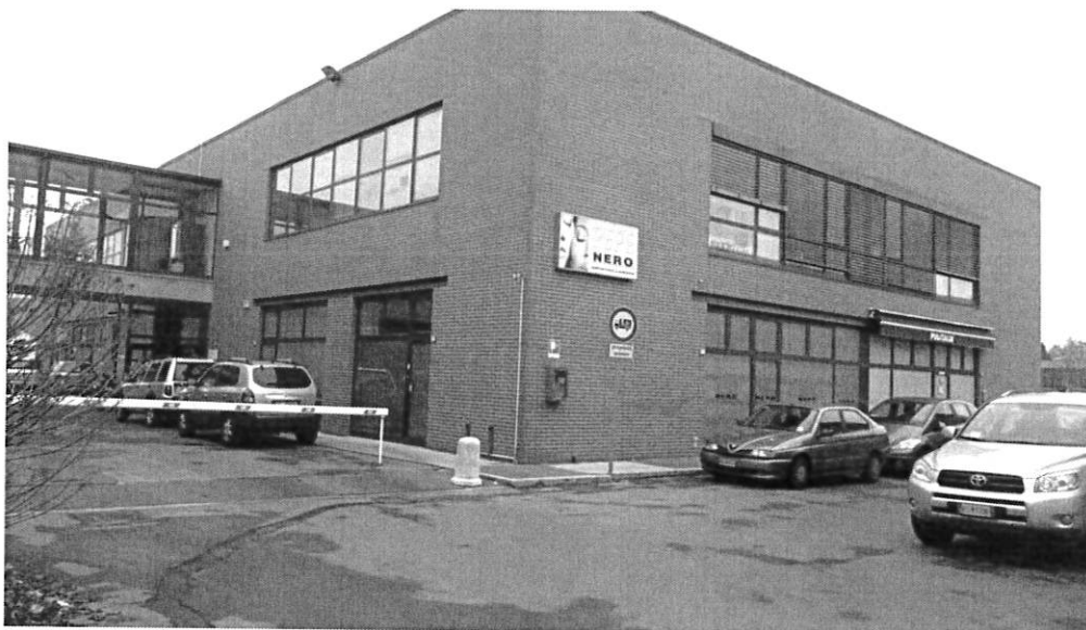
Vista esterna complesso
