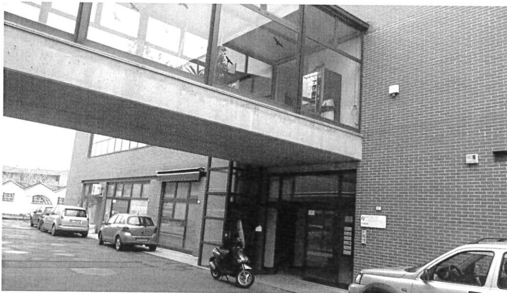
Vista esterna complesso
