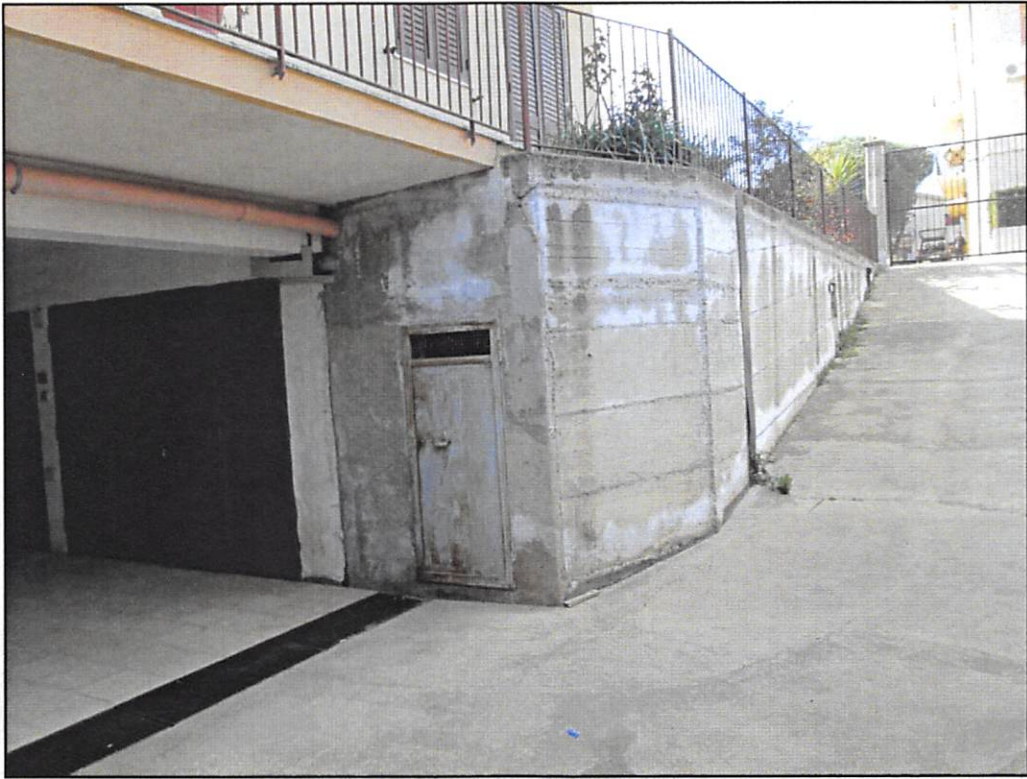
Foto 13: scivola di ingresso e garage oggetto di esecuzione
