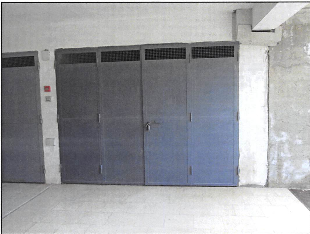
Foto 14: garage (vista esterna)
