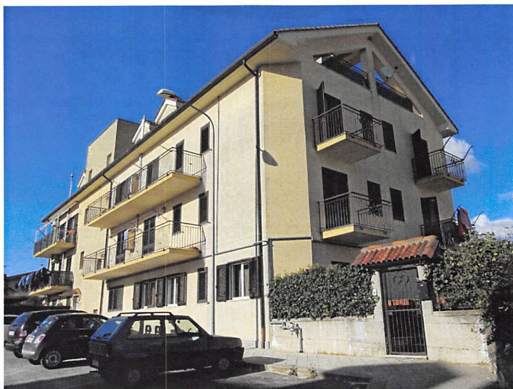
Foto 2: angolo prospetti sud-ovest e sud-est
