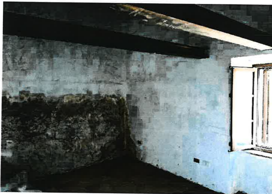
Foto 16: particolare camera -appartamento piano primo
