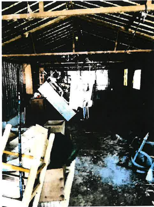
Foto 25: Particolare interno garage
