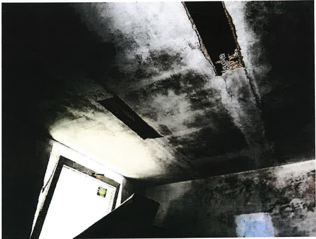
Foto 21: Particolare soffitto vano sotto terrazza -appartamento piano terra
