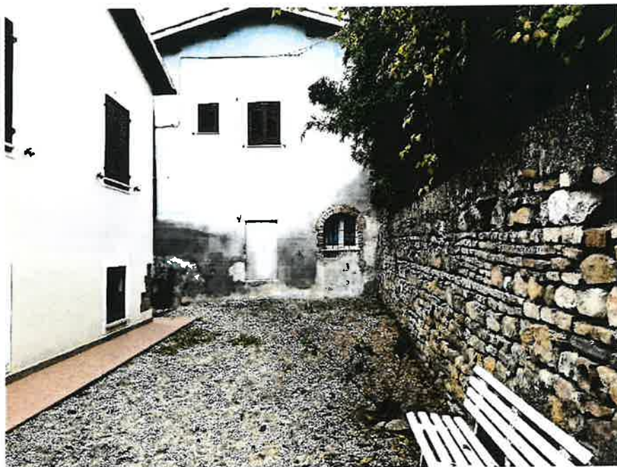
Foto 26: Particolare lato fabbricato con affaccio su altra proprietà
