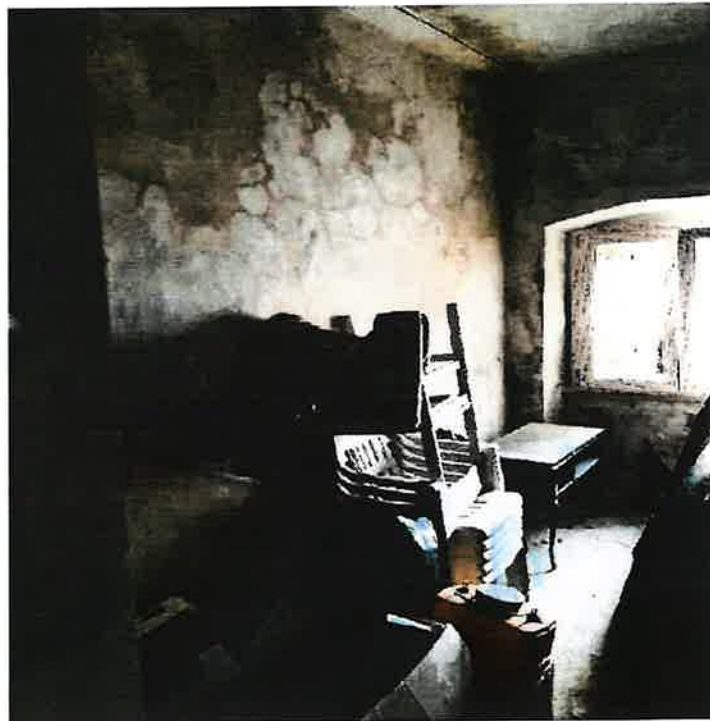
Foto 22: Particolare interni -appartamento piano terra
