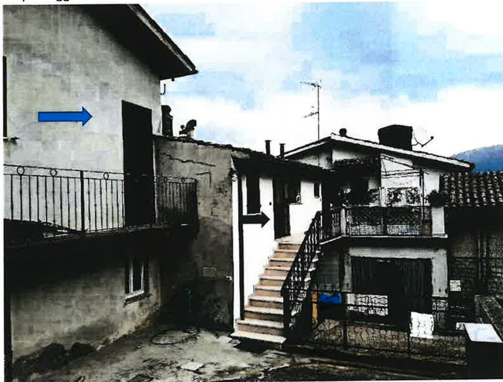
Foto 5 : attuale ingresso sub 12 - ex ingresso di diritto del sub 12 con passaggio attraverso sub 5
