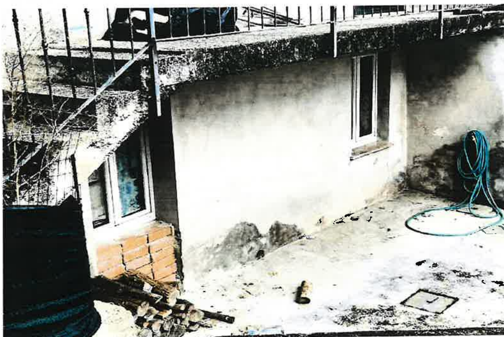
Foto 6: particolare finestrature appartamento piano terra versante sud-ovest, sotto scala ingresso sub 12.
