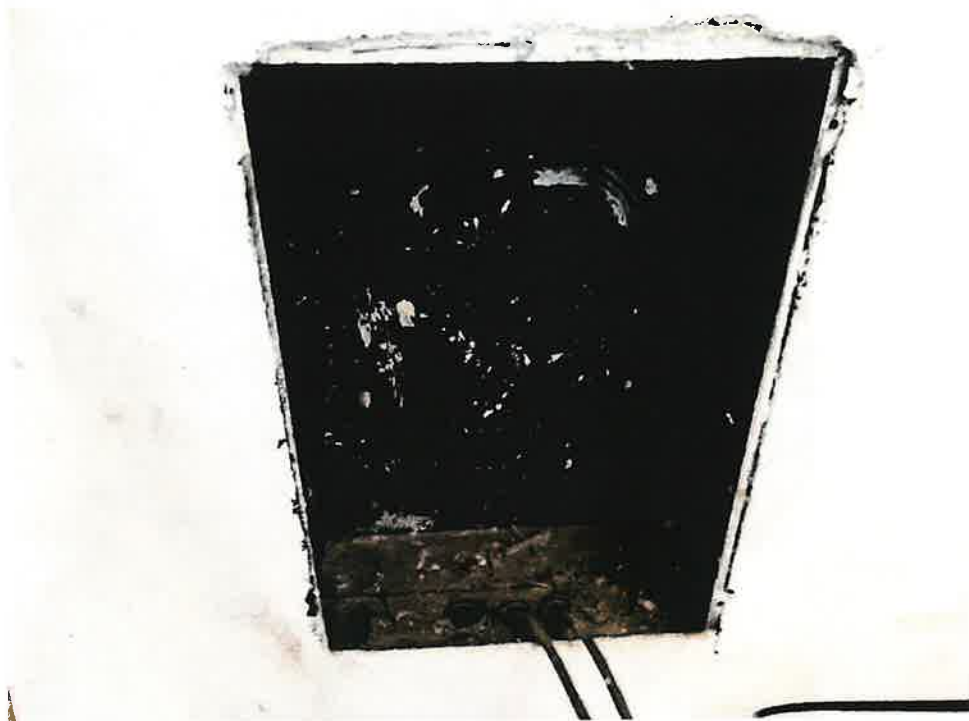
Foto 17: particolare incasso per centralina impianto di riscaldamento basale appartamento piano primo
