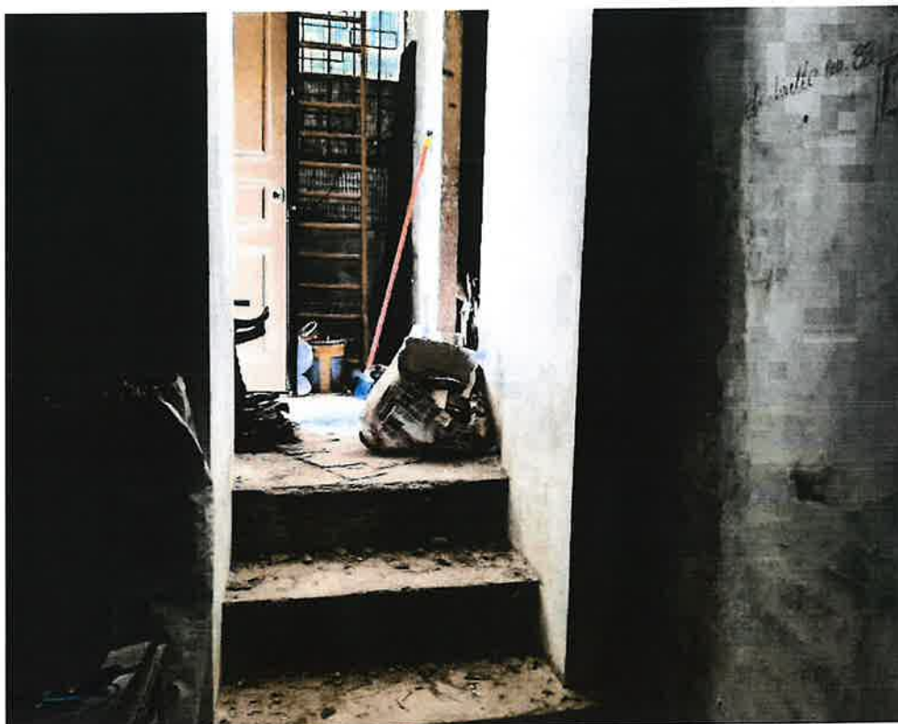
Foto 18: Particolare pianerottolo ingresso -appartamento piano terra
