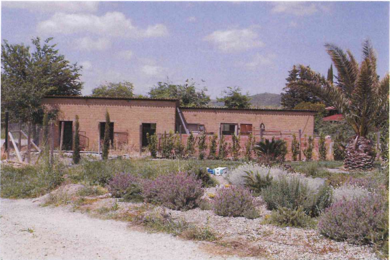
25. Veduta lato sud porcilaia
