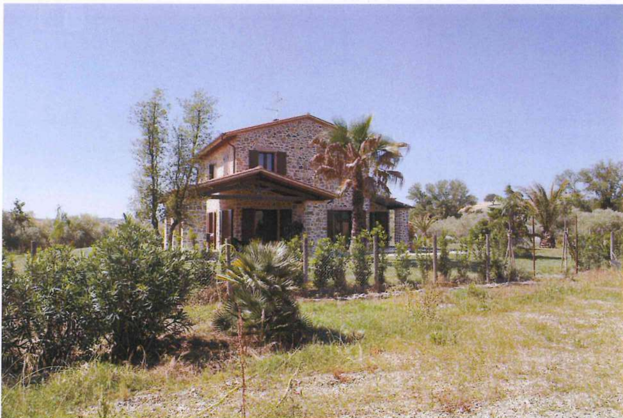
1. Veduta lato nord abitazione
