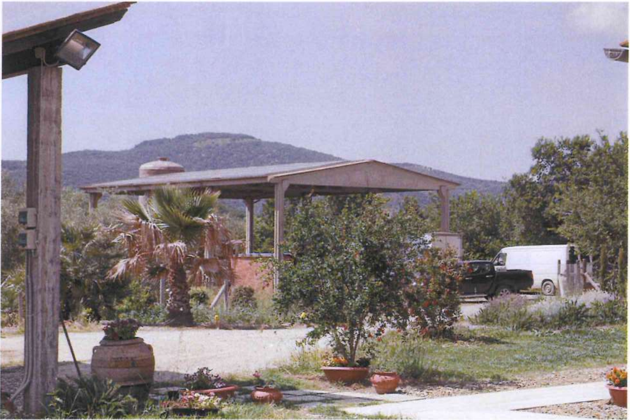
29. Veduta lato sud-est fienile. Sulla falda i pannelli fotovoltaici
