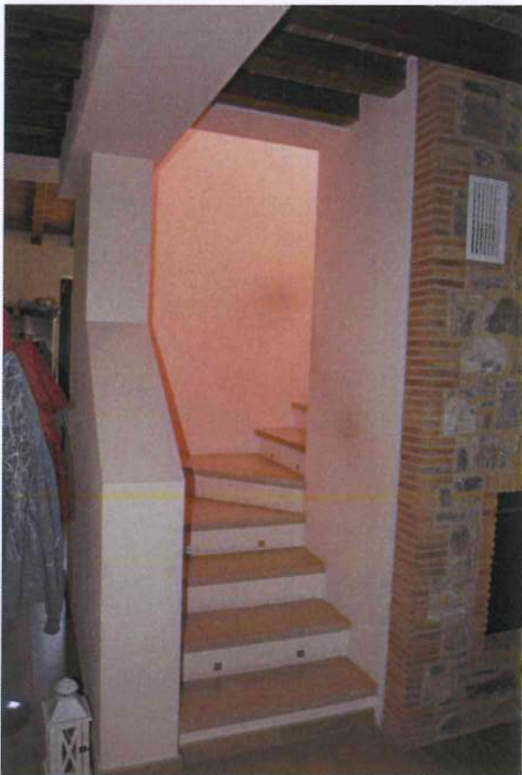
14. Scala di accesso al piano superiore
