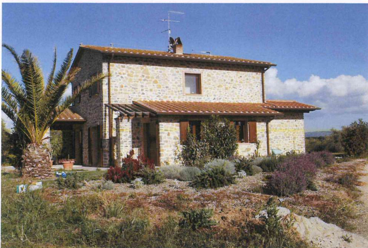
2. Veduta lato ovest abitazione
