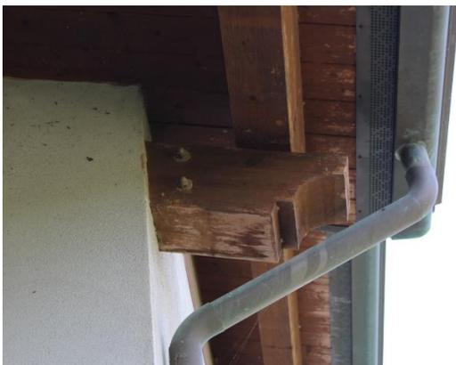
**PARTICOLARE GRONDAIA CON GRIGLIA PER LA VENTILAZIONE DELLA COPERTURA**
