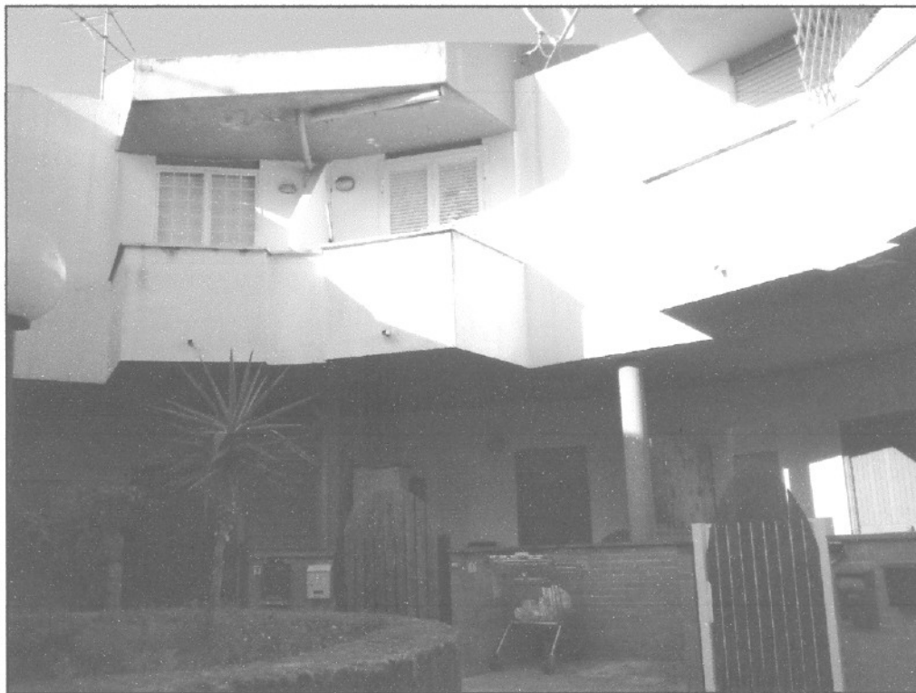
FOTO 1 – Vista esterna lato corte –
