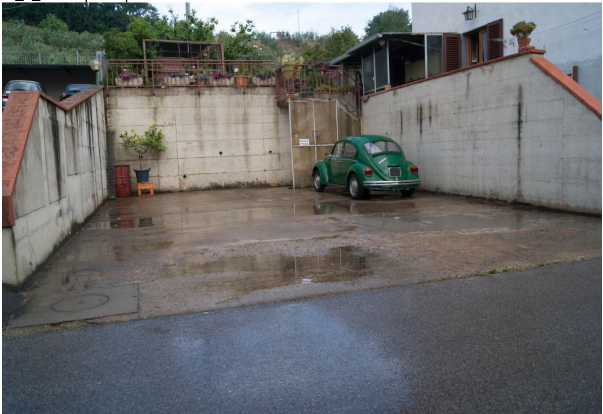
Foto_2_ Vista piazzale esterno
