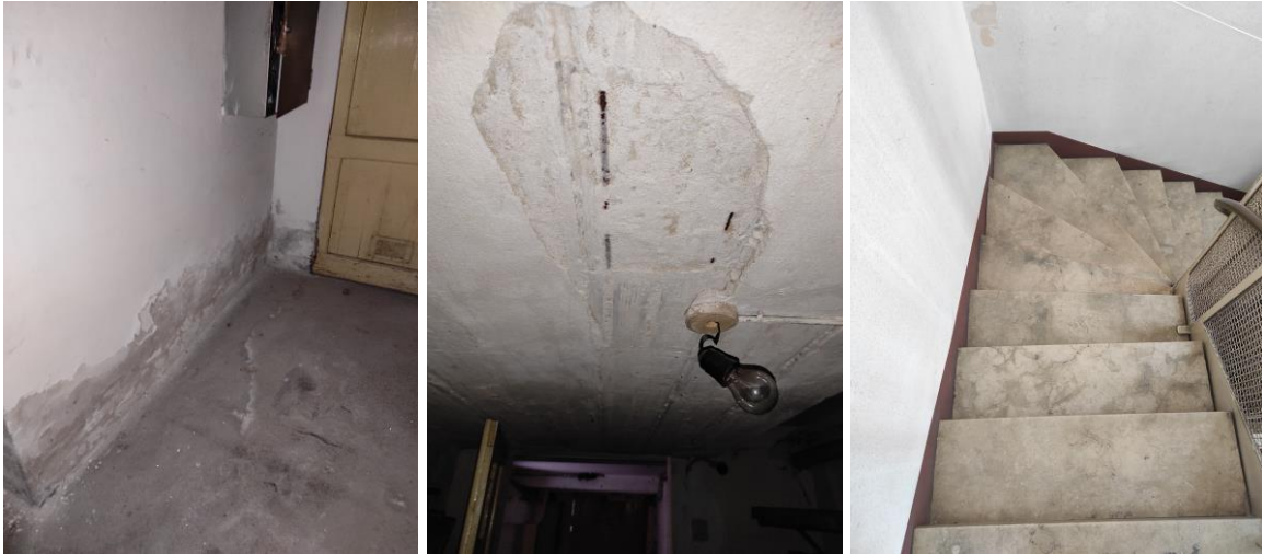
Parti comuni: disimpegno del piano interrato e scala B
