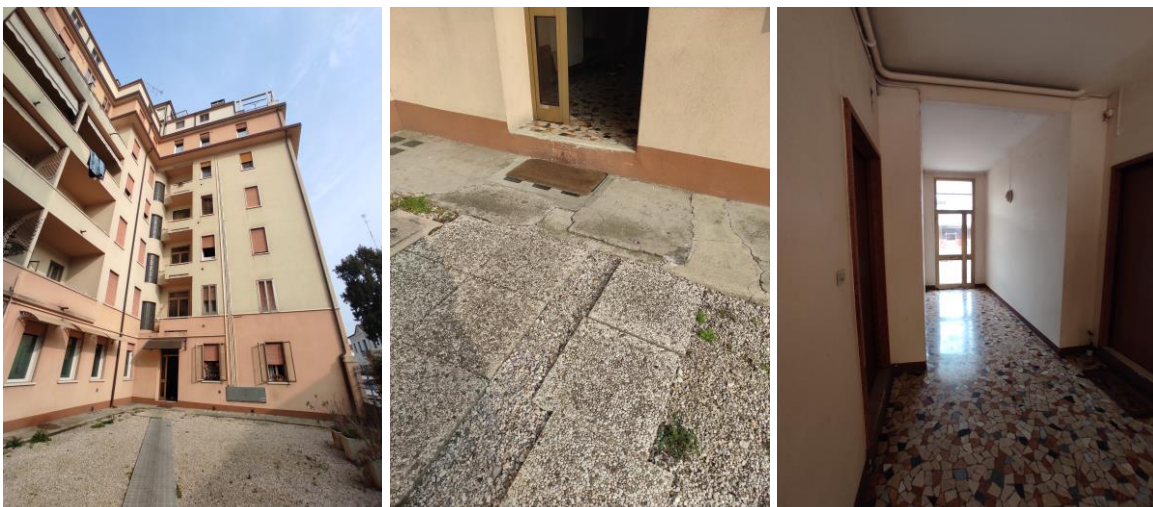
Porzione nord del fabbricato, ingresso comune
