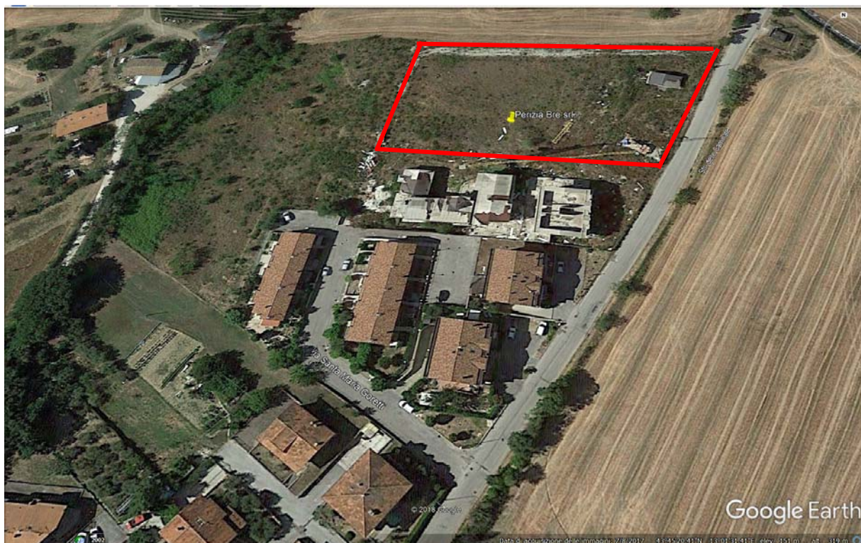
LOCALIZZAZIONE IN MAPPA DELL'EDIFICIO IN OGGETTO IN STRADA DELLE CAMINATE – LOCALITA' LA CERASA - SAN COSTANZO
