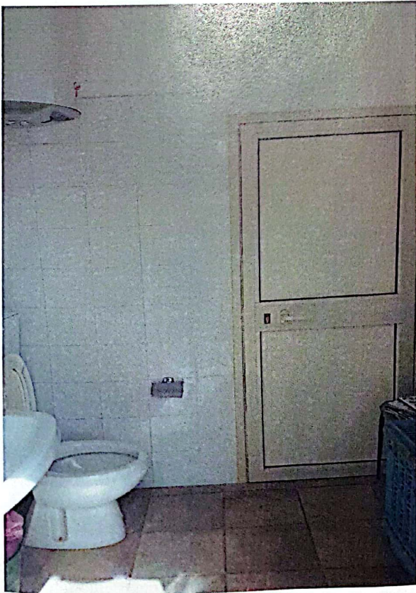
Foto 8 : Vista wc, interno al fabbricato in Carlentini foglio 17 part. 681
