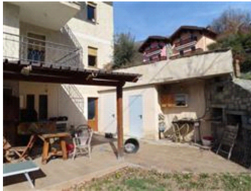
tettoia e locali bruciatore su area comune
