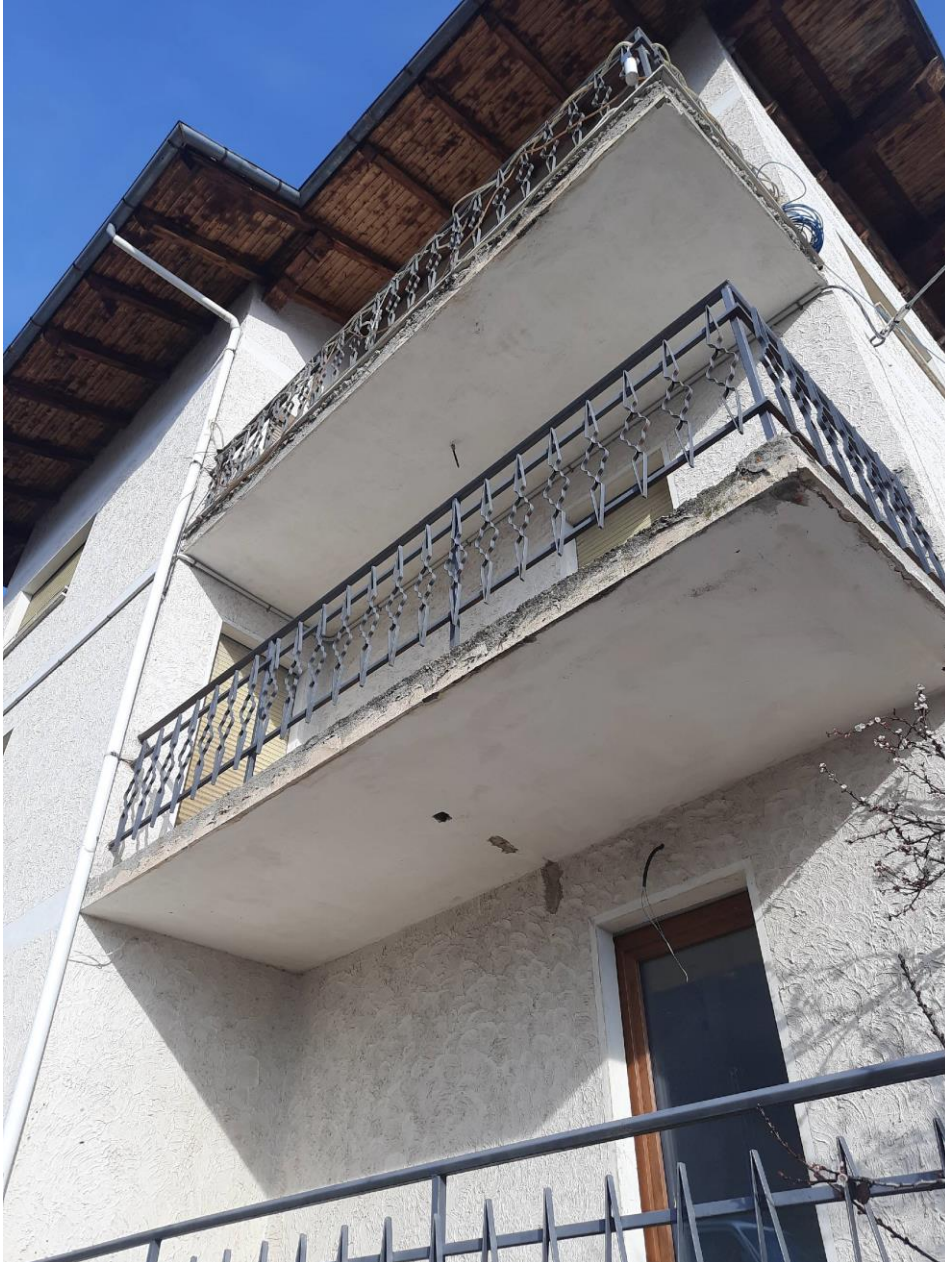
PARTICOLARE CHE DENOTA LO STATO CONSERVATIVO DI ALCUNE PARTI DEL FABBRICATO
