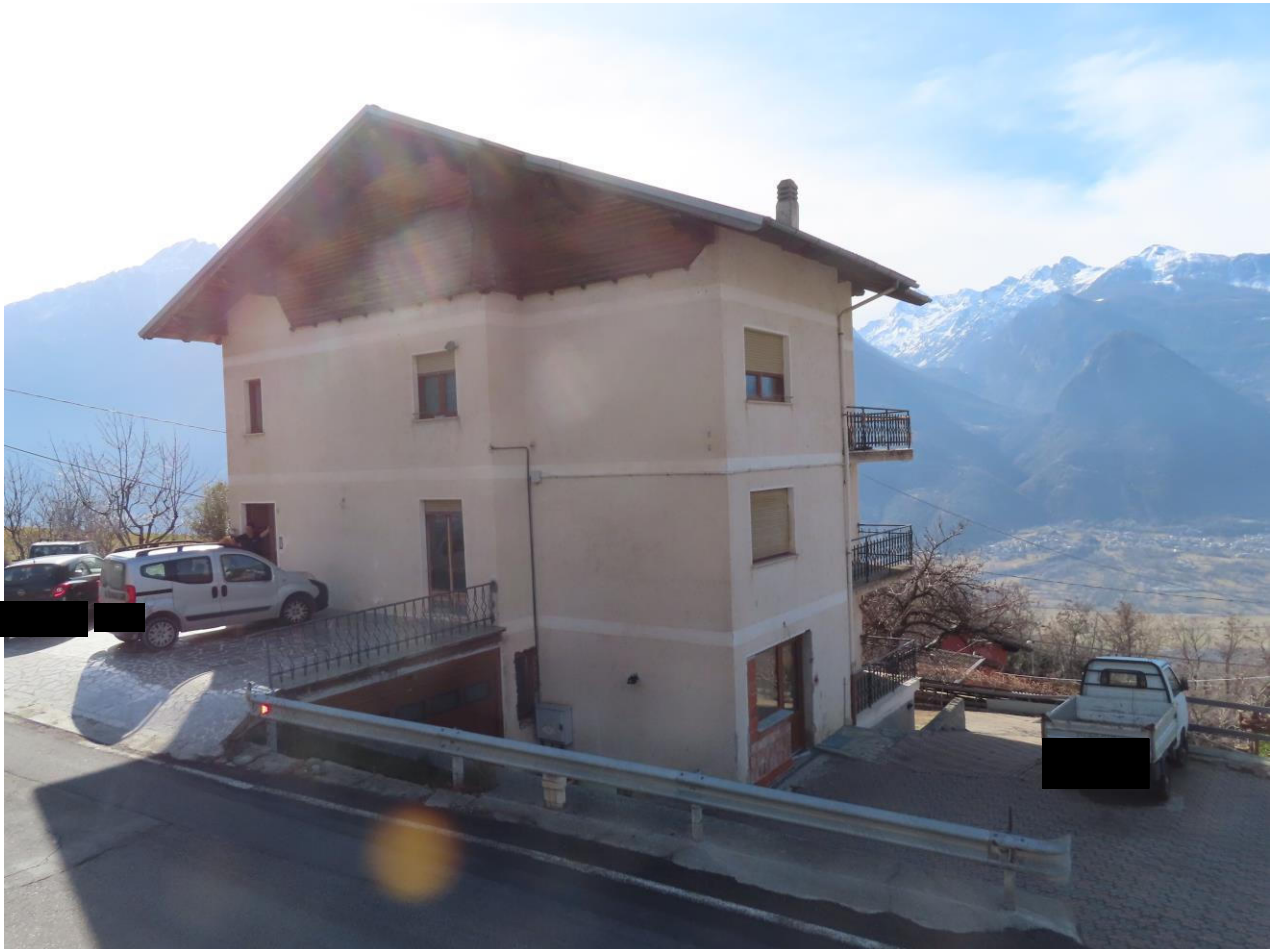
VISTA NORD/OVEST(vedasi l'area parcheggio e la porta autorimessa in basso)
