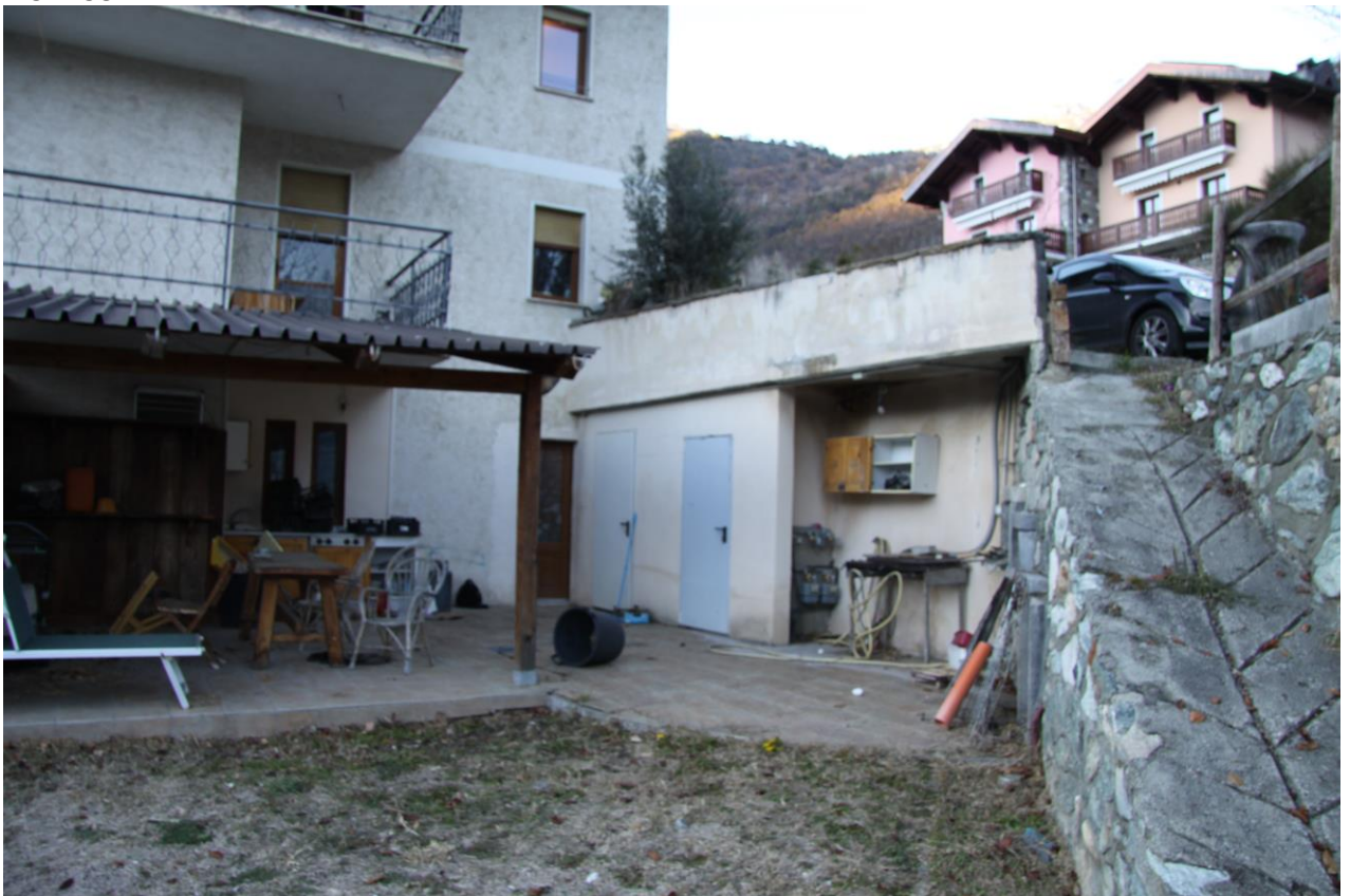
VISTA AREA COMUNE A EST PIANO 1° SEMINTERRATO CON LOCALE BRUCIATORE E TETTOIA
