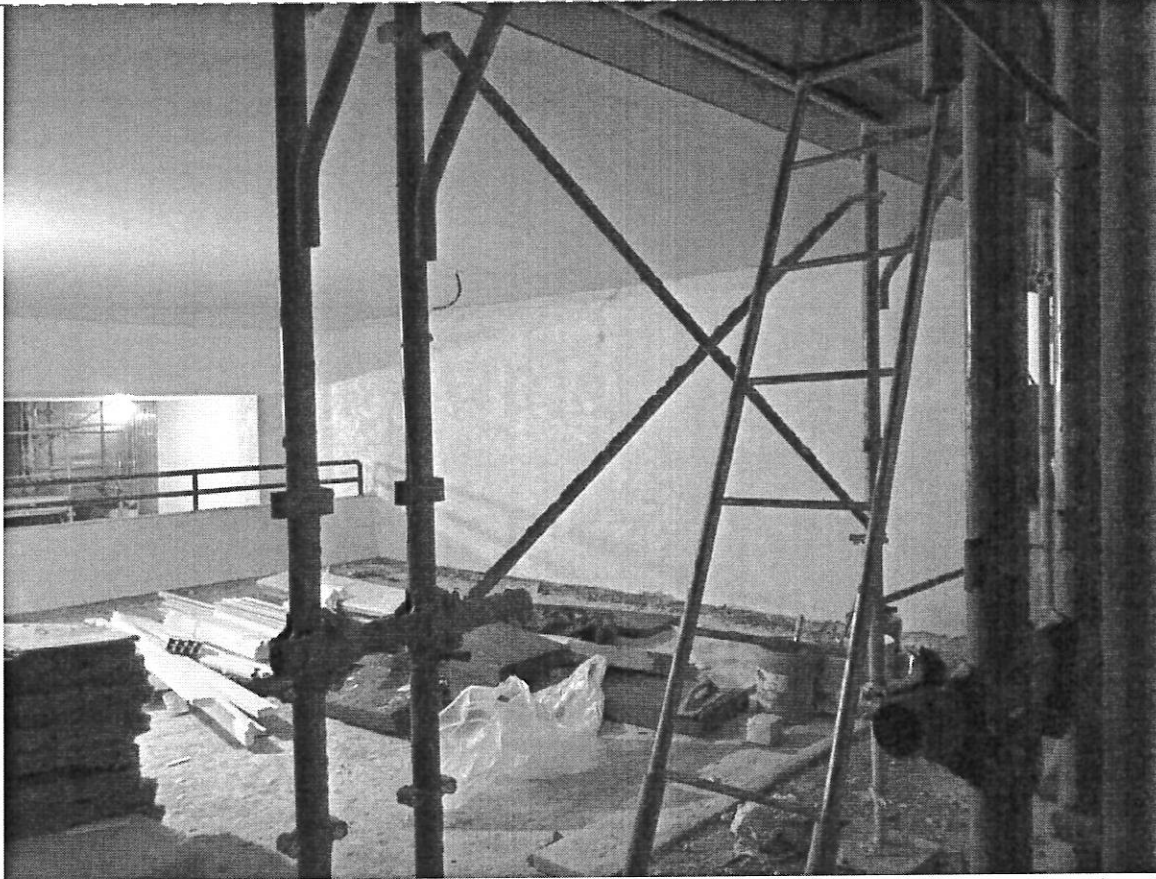
Foto 21 – posto auto coperto a piano terra
