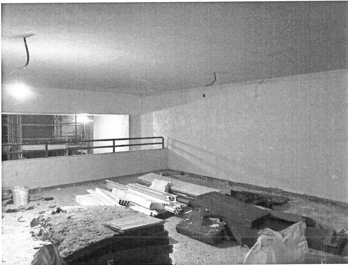
Foto 22 – posto auto coperto a piano terra
