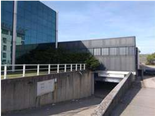
Rampa carraia di accesso
