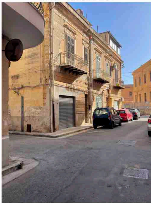
Fotografia n. 1 vista angolare dell'edificio
