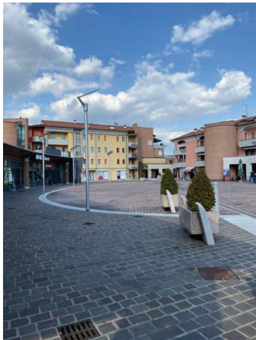
Foto 1 – Facciata esterna condominio
