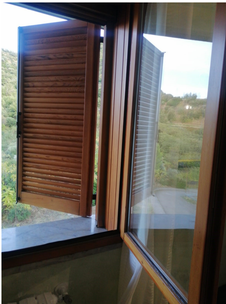
Foto n. 5 – particolare infisso esterno in legno
