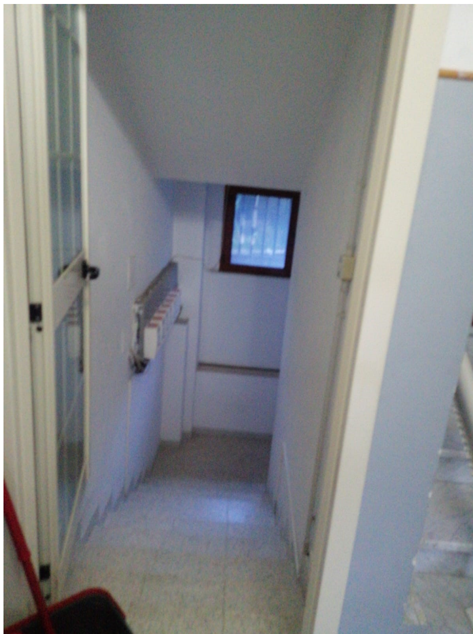
Foto n. 6 – vano scala condominiale
