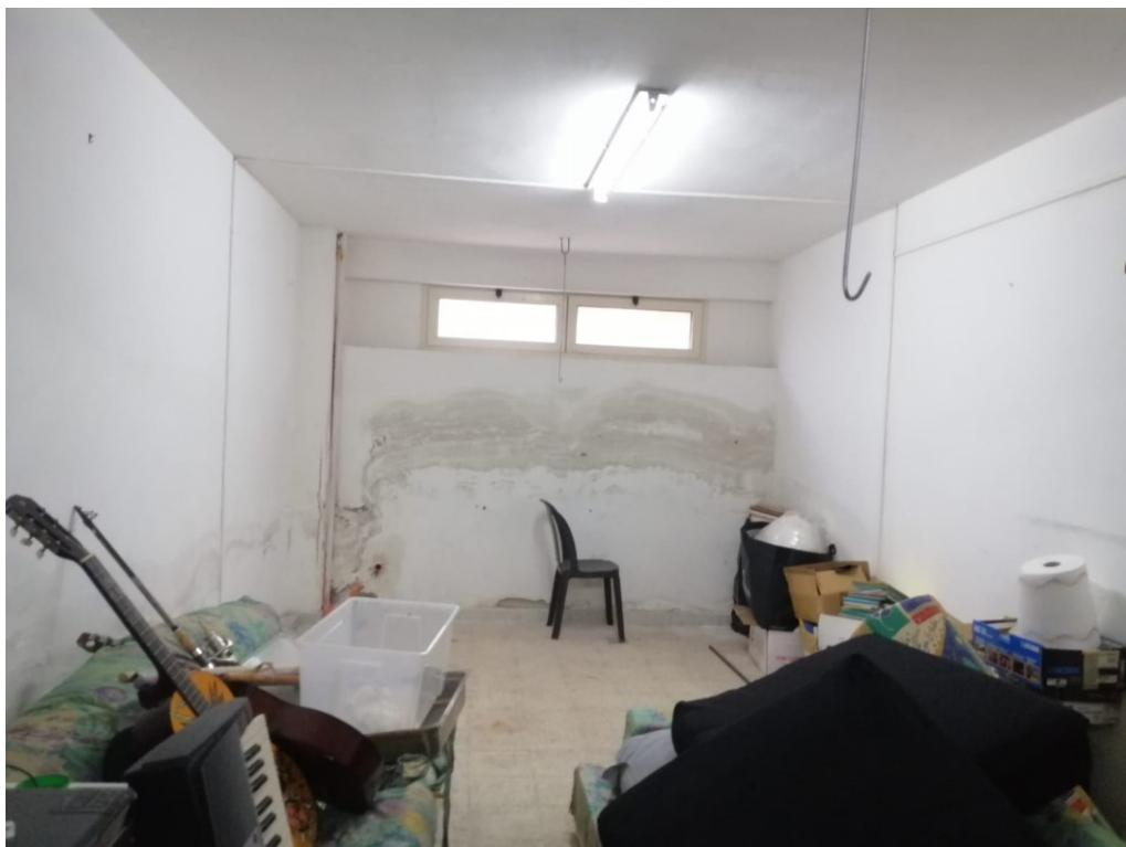
Foto n. 10 – interno ripostiglio al piano seminterrato
