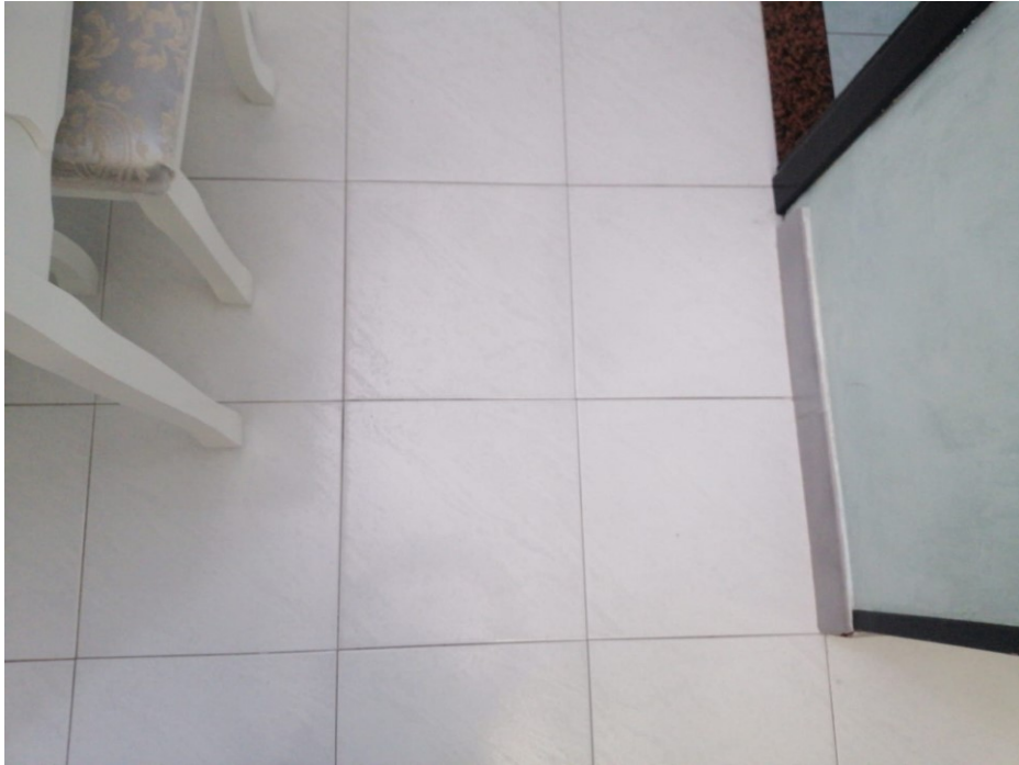
Foto n. 7 – particolare pavimento interno
