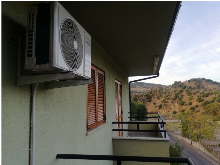
Foto n. 4 – particolare balcone su prospetto posteriore
