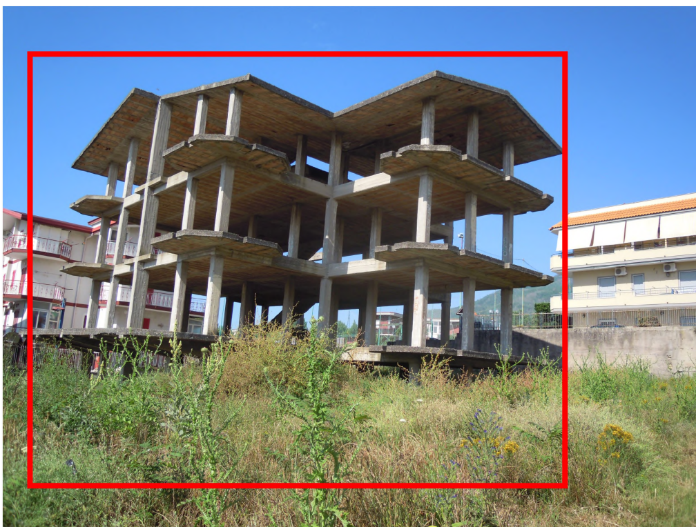
Fig.4- Veduta del telaio in c.a. (rettangolo rosso) all'interno del terreno di proprietà convenuta di via Arena San Vito snc Ercolano (Na)
