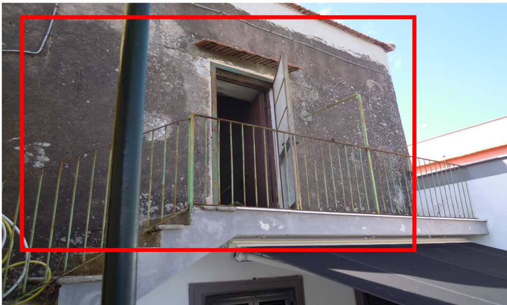
Fig.3- Ingresso appartamento via San Vito n. 12 Ercolano (Na).
