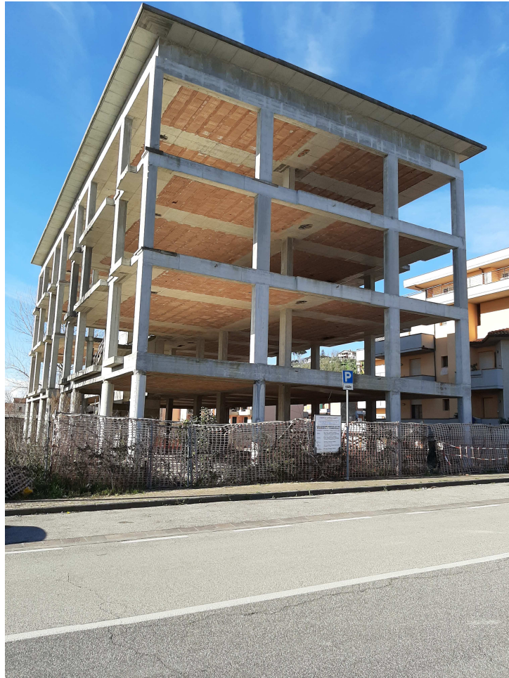
Vista del fabbricato da via Buozi
