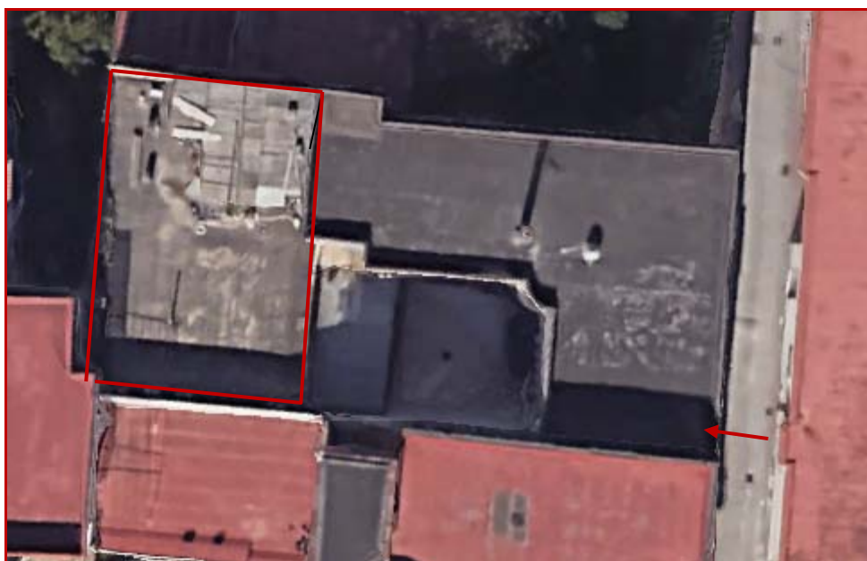
Vista aerea del complesso di via Frezza n. 123/4 con evidenza del manufatto staggito
