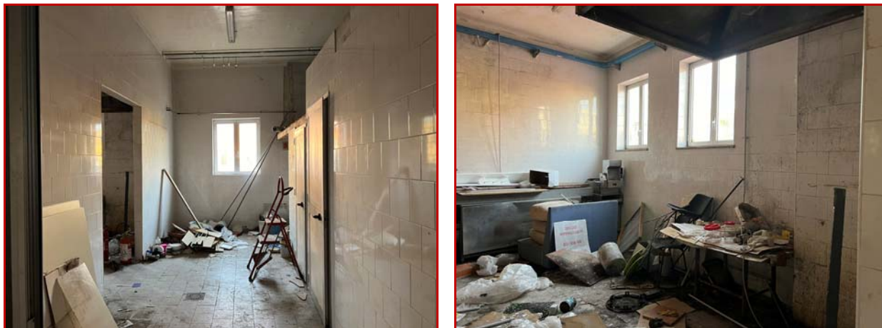
Viste del disimpegno con blocco servizi e del secondo ambiente di lavorazione
