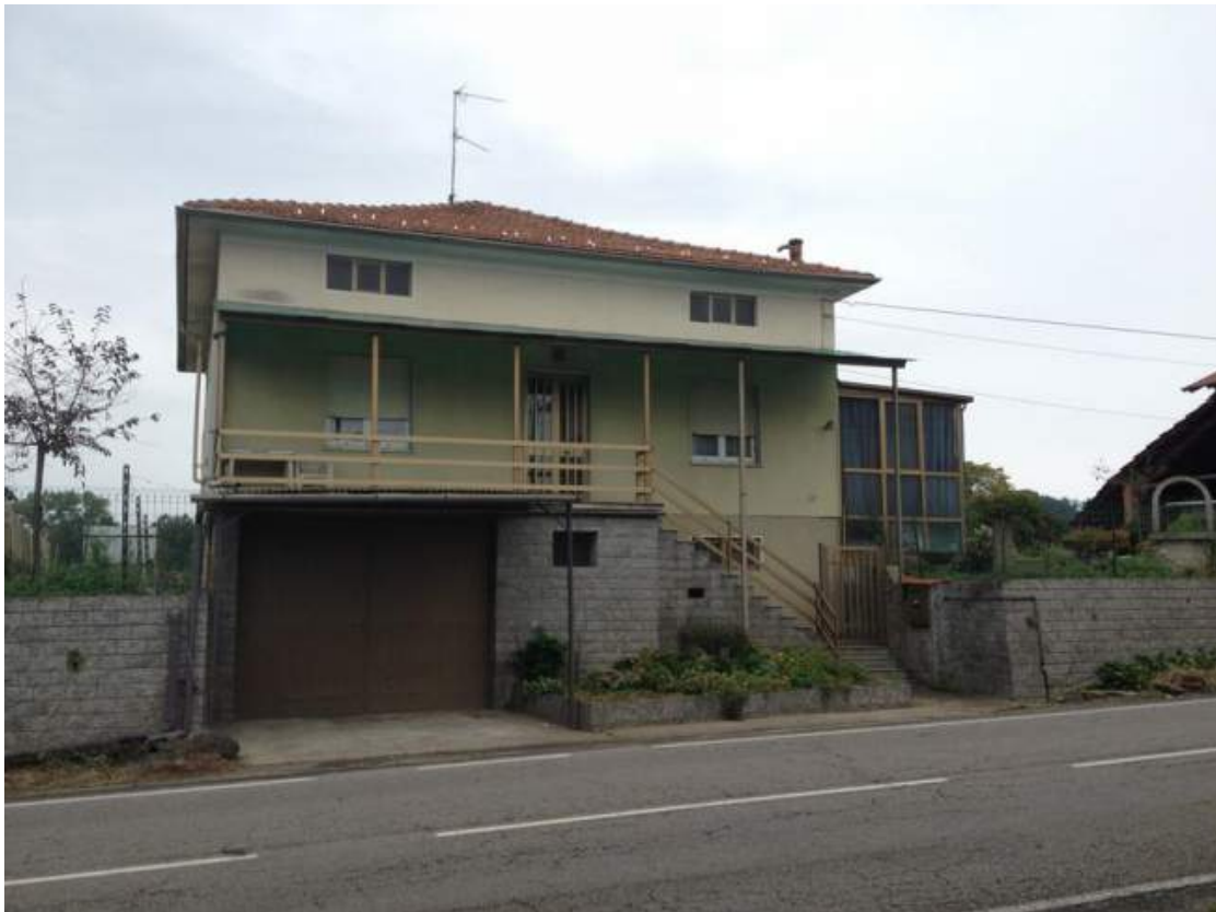
IMMOBILE in Gattico (A) – prospetto sud-est - vista da corso Garibaldi
