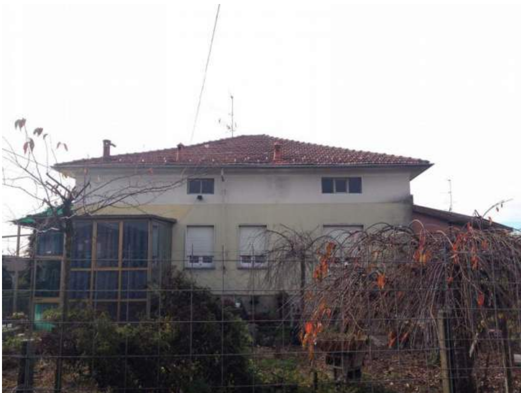
IMMOBILE in Gattico (A) – prospetto nord-est - vista da mapp.405
