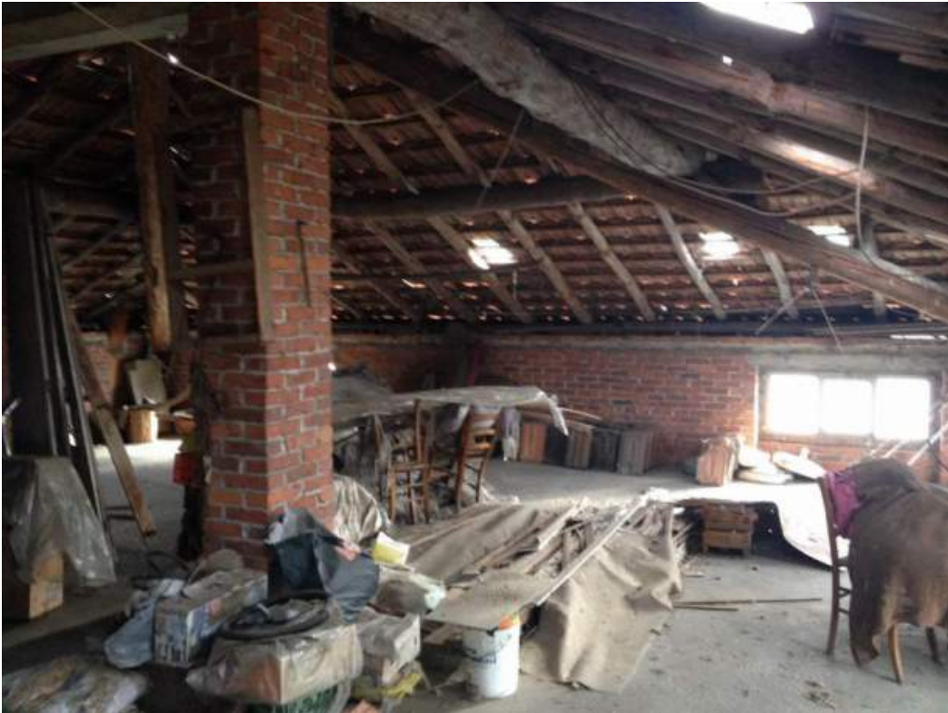
IMMOBILE in Gattico (A) – sottotetto non abitabile
