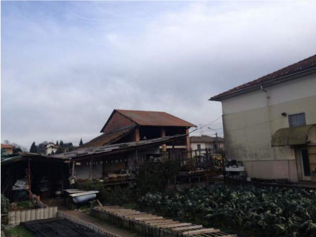
IMMOBILE in Gattico (D) e (B) – prospetto sud-ovest - vista da corte interna (C.3)
