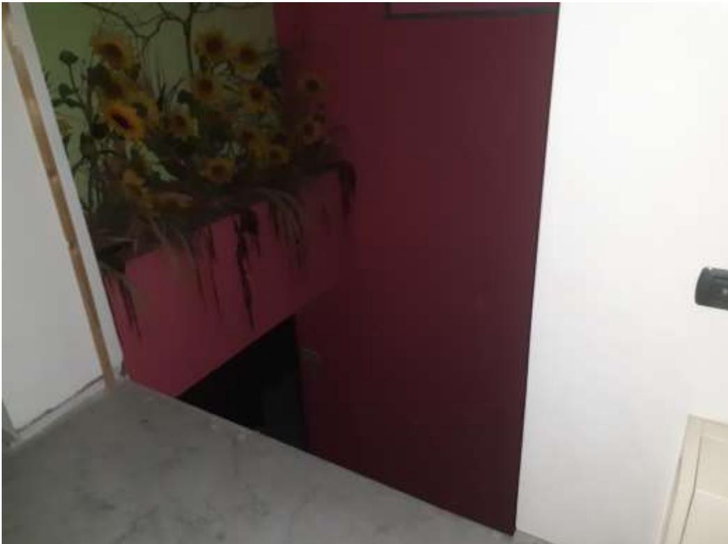
10. Interno: piano terreno -negozio. Si evidenzia la mancanza della scala e del vuoto del vano sino al piano sottostante
