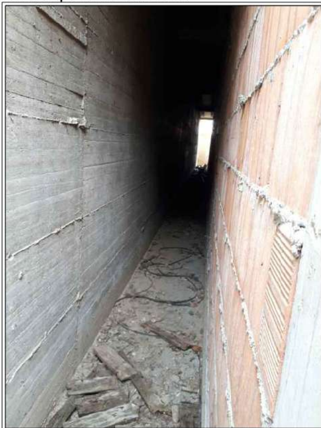
Intercapedine lato sud
