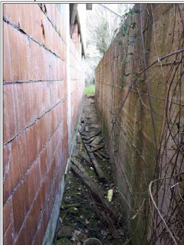
Intercapedine lato est
